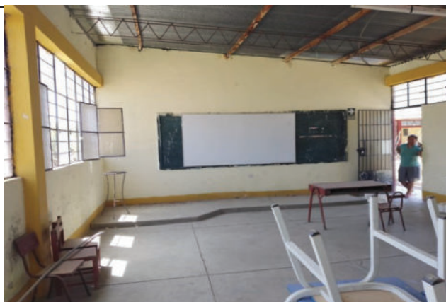
Vista interior de aula, se observa cobertura liviana con calaminas galvanizadas dispuestas en viguetas de madera y celosía de fierro.
