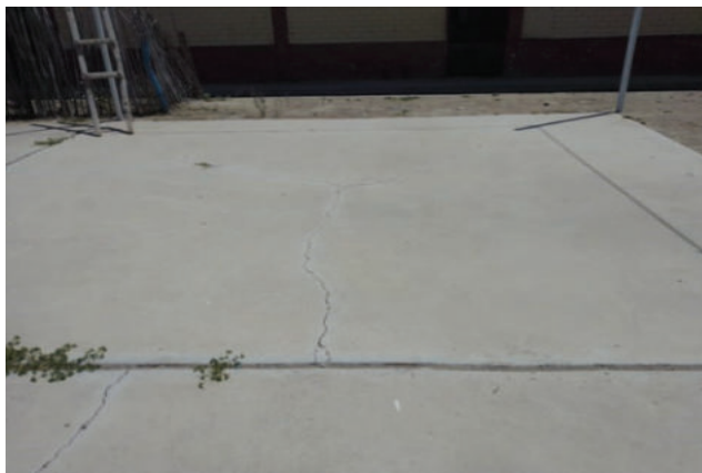
Vista de grietas en patios, dichas fallas se repiten en pisos y veredas
