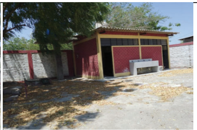
Vista de ss.hh., se observa tanque elevado prefabricado, techo de cobertura liviana
