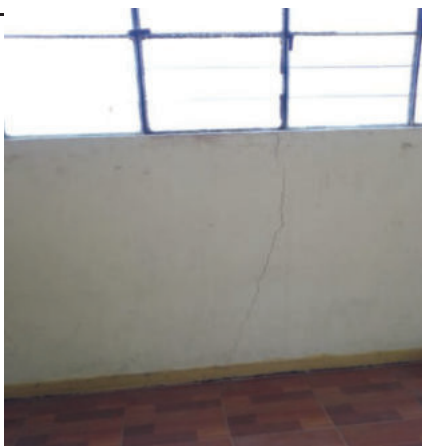
Vista de aula, se observa grietas en los muros
