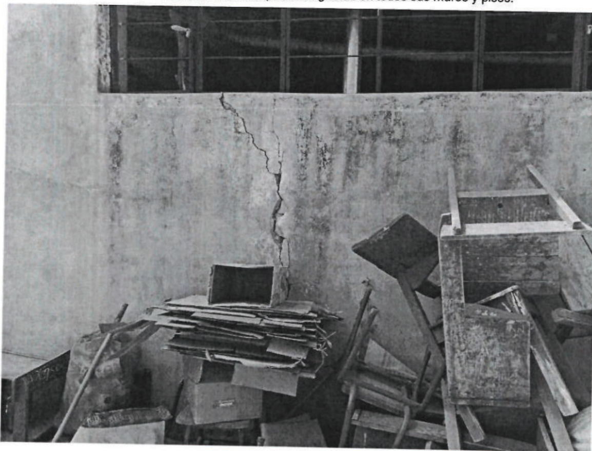
Foto N° 04: Vista Interior. Ambiente presente grietas en todos sus muros y pisos.
