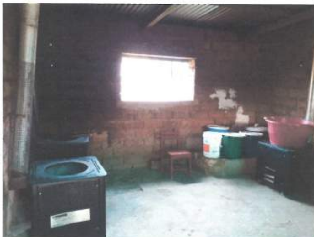
Foto N° 02: vista exterior de la edificación, no se observa daños en la infraestructura, falta revestimiento en las paredes, falta colocación de vidrios en las ventanas.
