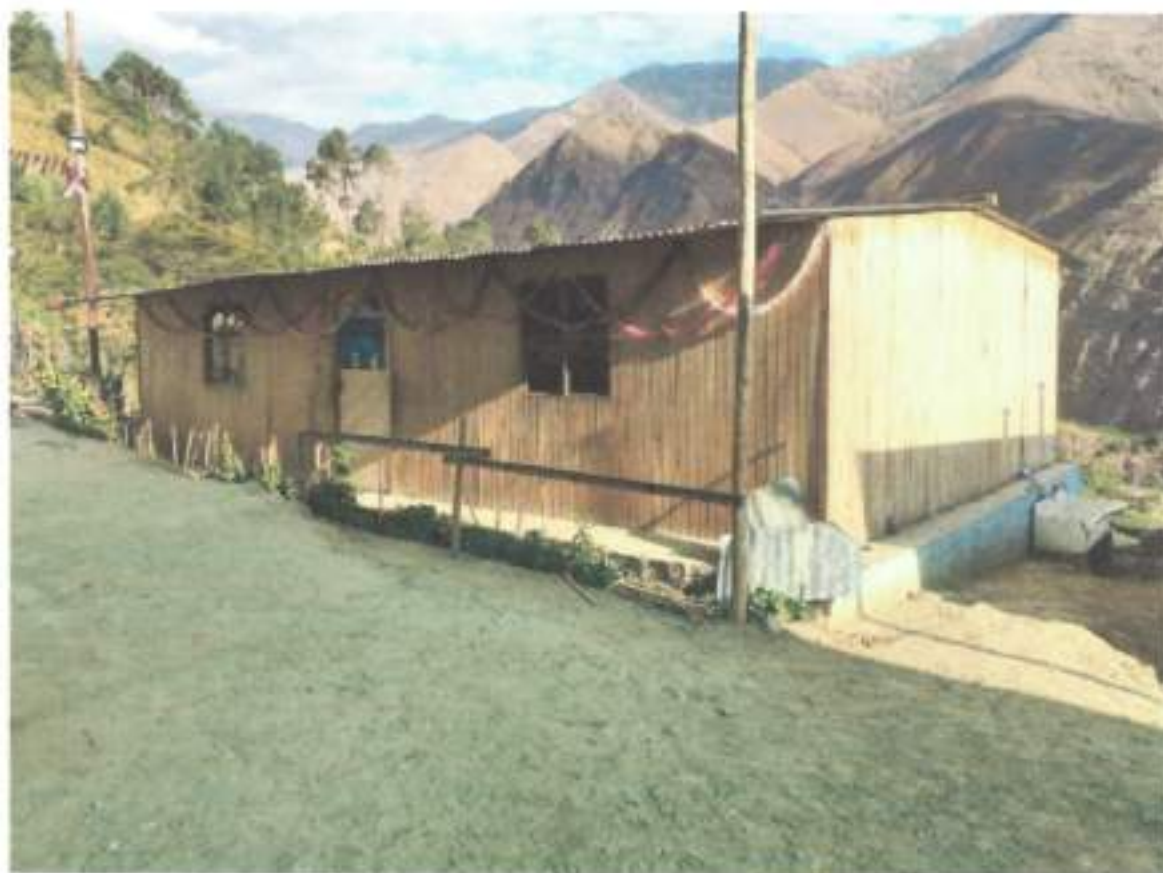
Foto N° 01: vista exterior, del módulo prefabricado instalado por la UGEL el año 2017 fecha en que se presentó el ingreso del agua a las aulas de adobe de la I.E. a la fecha las maderas por las condiciones climáticas del lugar se están deteriorando, no cuentan con un adecuado sistema de drenaje pluvial.
