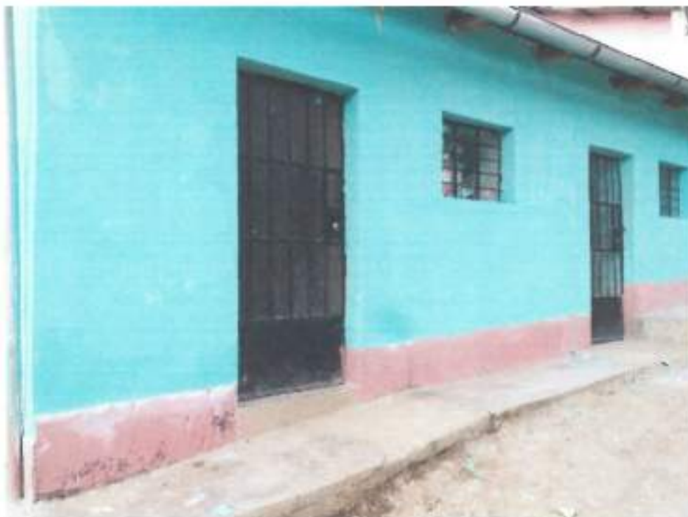
Foto N° 01: vista exterior de la edificación, el día de la inspección se estaba realizando el trabajo de mantenimiento como resanes del revestimiento dañado y pintado, se observa fisuras superficiales en las paredes, deterioro del adobe de la parte baja de la pared, fisuras en veredas.
