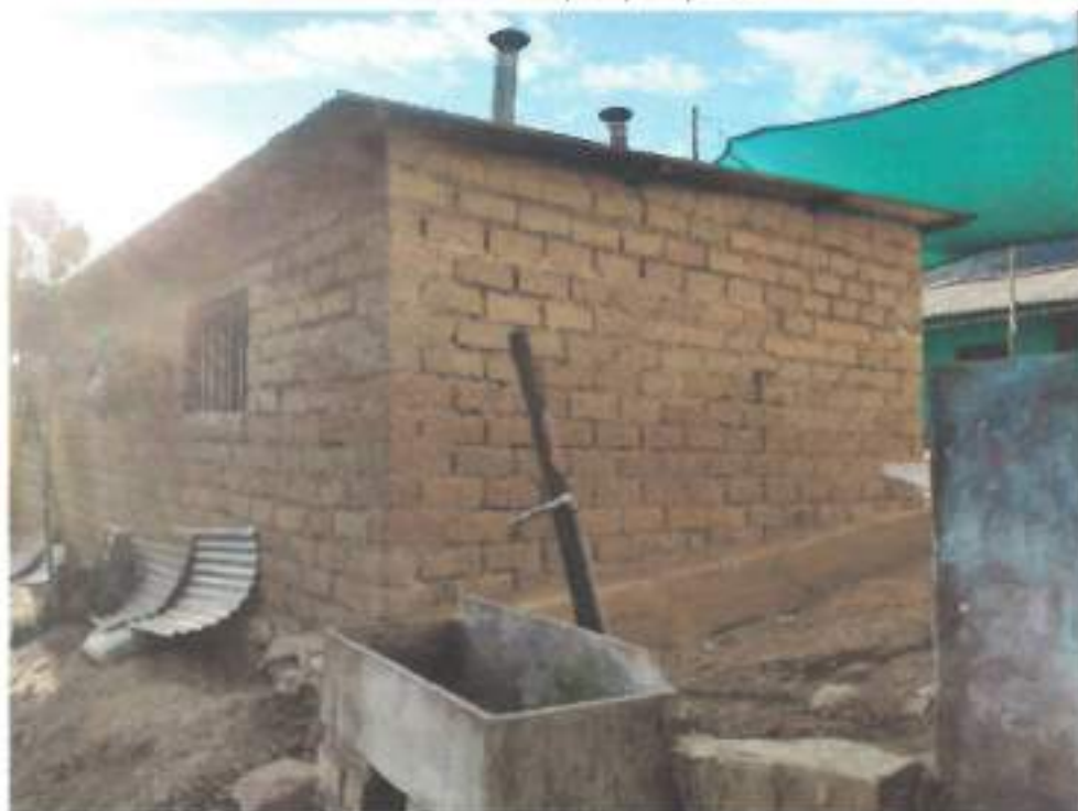
Foto N° 02: vista exterior de la edificación, no se observa daños en la infraestructura, falta revestimiento en las paredes, falta colocación de vidrios en las ventanas.
