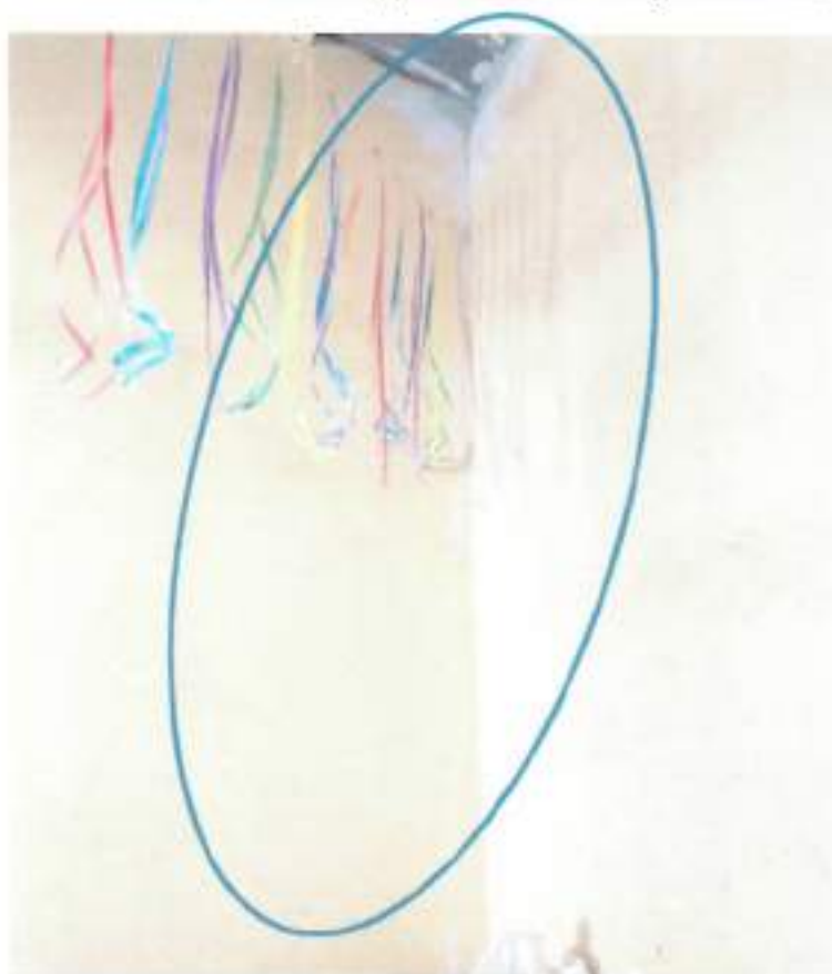
Foto N° 04: vista del interior de uno de los ambientes, presenta fisuras en la unión de ambas paredes.
