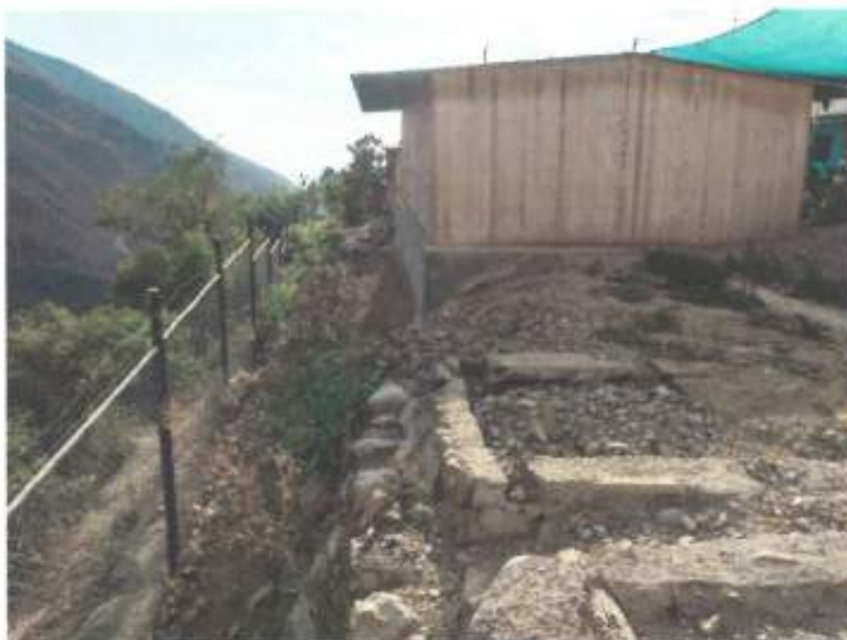
Foto N° 02: vista posterior del módulo prefabricado de madera, requiere trabajos de mantenimiento, para conservar la madera que al estar expuesto a la intemperie se está deteriorando.
