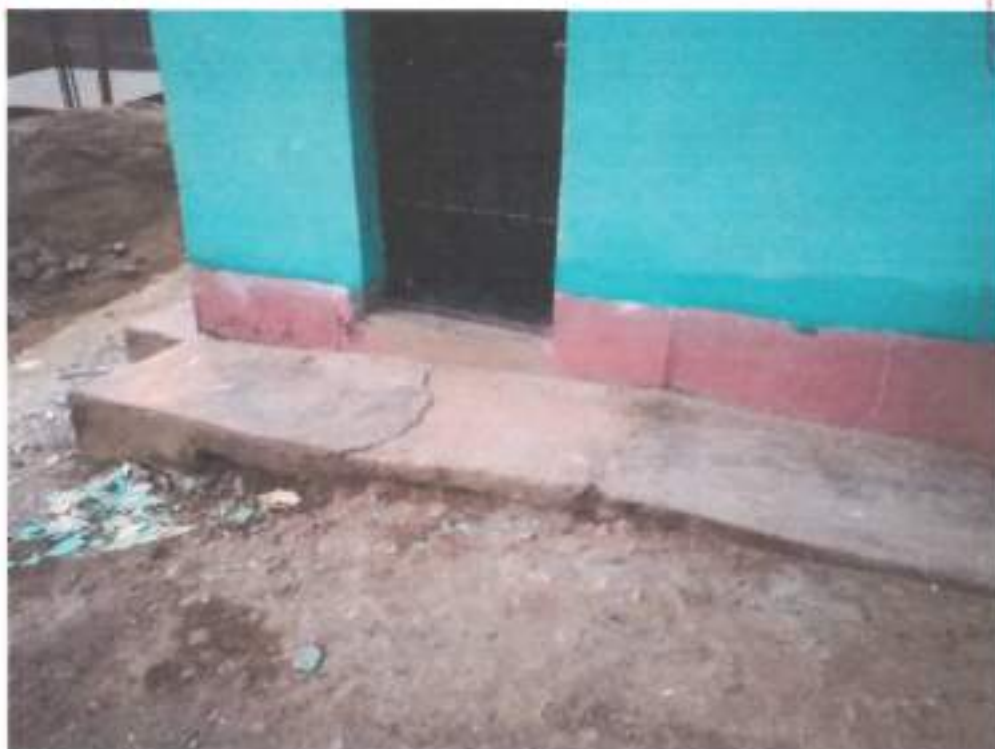
Foto N° 03: vista exterior de la parte que inferior del muro que se está resanando debido al deterioro del adobe y desprendimiento del revestimiento.
