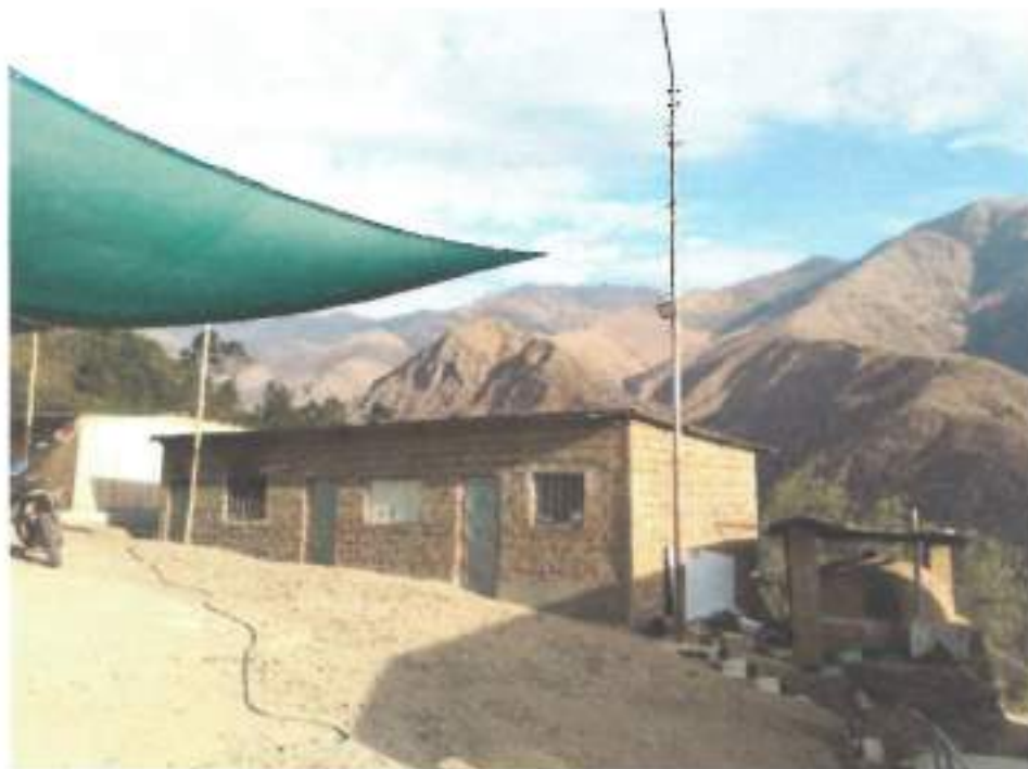
Foto N° 01: vista exterior, de la edificación de adobe, no se observa daños en la infraestructura, todas las paredes exteriores no se encuentran revestidos, el alero del techo es corto, no tiene un adecuado sistema de drenaje pluvial, se requiere realizar un mantenimiento preventivo.
