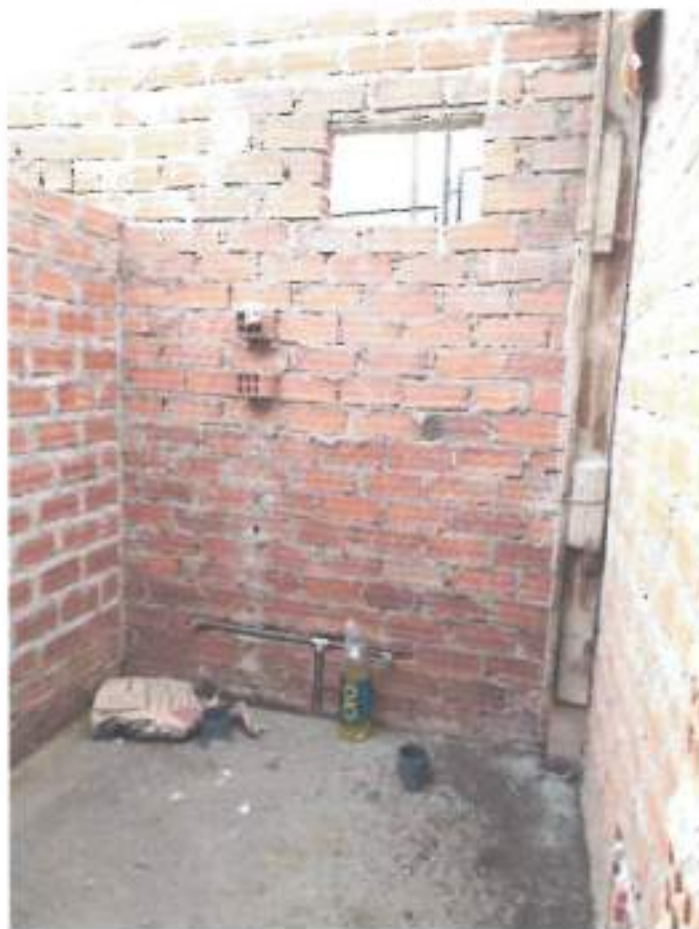
Foto N° 02: vista del interior de la edificación en construcción, se observa algunas deficiencias técnicas como la falta de dintel en los vanos, no cuenta con sobrecimiento.
