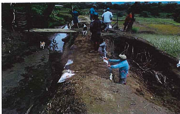
Canal en mal estado, pobladores realizando una reparación
