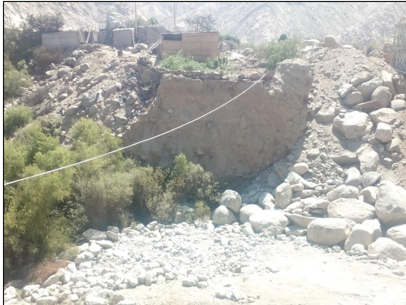
Vista 01: Tubería de conducción de agua (pase aéreo) potable existente en malas condiciones.
