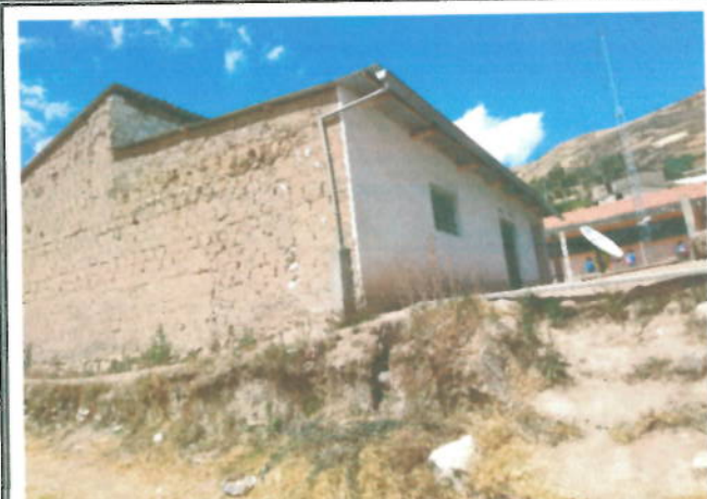
DESCRIPCIÓN: MÓDULO (D1) DE MATERIAL RÚSTICO CONSTRUIDO EN EL AÑO 1992 POR LA APAFA Y SIN DIRECCIÓN TÉCNICA. REPARADO Y PINTADO RECIENTEMENTE CONMANTENIMIENTO. SE APRECIA LA ESTRUCTURA DE ABOBE INADECUADA. ADEMÁS EXISTE DESNIVEL DEL TERRENO QUE AUMENTA EL PELIGRO.
