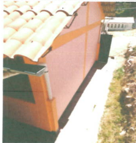
DESCRIPCIÓN:MODULO (A1) CONSTRUIDO CON APOYO DE LA MUNICIPALIDAD DISTRITAL EN EL AÑO 2009, INCLUYE DIRECCIÓN TÉCNICA. EN BUENAS CONDICIONES. AQUÍ FALTA DRENAJE PLUVIAL.
