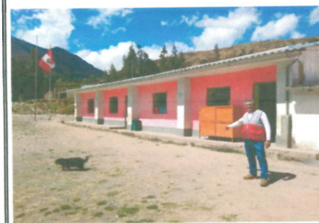
DESCRIPCIÓN: MÓDULOS (A2, A3, A4) DE MATERIAL RÚSTICO CONSTRUIDOS EN EL AÑO 1995 CON APOYO DE FONCODES. SE APRECIA LA FALTA DE DRENAJE PLUVIAL EL CUAL AFECTA LAS VEREDAS PERIMETRALES, PROLONGANDOSE LAS FISURAS A LOS MUROS AFECTANDO SU ESTRUCTURA.
