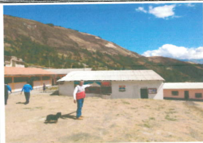
DESCRIPCIÓN: MÓDULO (D1) DE MATERIAL RÚSTICO CONSTRUIDO EN EL AÑO 1992 POR LA APAFA Y SIN DIRECCIÓN TÉCNICA. REPARADO Y PINTADO RECIENTEMENTE CONMANTENIMIENTO. SE APRECIA LA ESTRUCTURA DE ABOBE INADECUADA.
