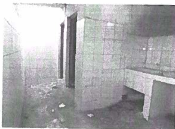
Foto N° 02: Vista interior de servicios higiénicos clausurados, se observa piso hundido y fisuras
