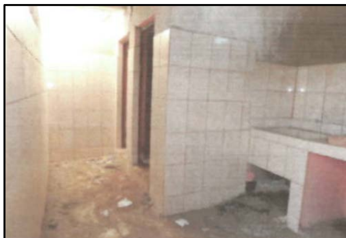
Vista fotográfica N° 02.- Vista del interior del servicio higiénico clausurado, existen fisuras en muros y desnivelación de piso
