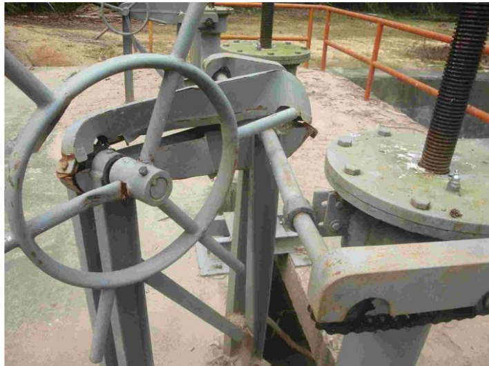
FOTOGRAFÍA 4. Mecanismo de izaje y tornillo Averiado.
