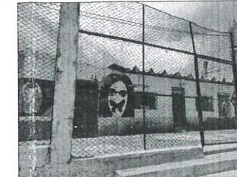
VISTA FOTOGRÁFICA 05: DETALLE POSTERIOR DEL ESTADO ACTUAL DE LAS COLUMNETAS, SOBRECIMENTOS Y MALLA METÁLICA EXISTENTE
