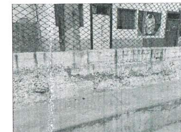
VISTA FOTOGRÁFICA 14: DETALLE DEL ESTADO ACTUAL DE LA LOSA DEPORTIVA. PRESENTA AGRIETAMIENTO Y ABOLLADURAS
