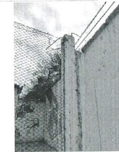
VISTA FOTOGRÁFICA 12: DETALLE DEL ESTADO ACTUAL DE LAS COLUMNETAS EXISTENTES PRESENTA DESCASCARAMIENTO Y GRIETAS
