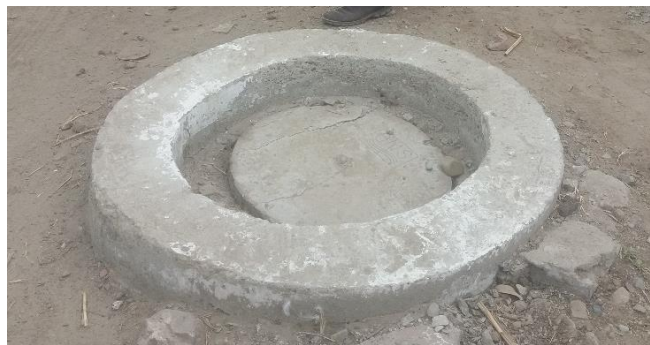
La foto muestra el típico mal estado de conservación de los buzones
