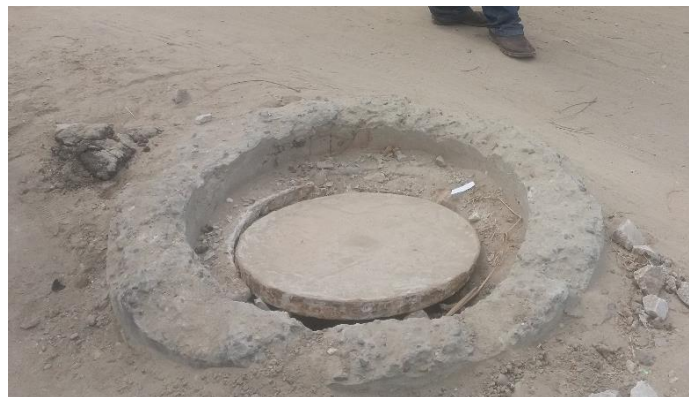
La foto muestra el típico mal estado de conservación de los buzones
