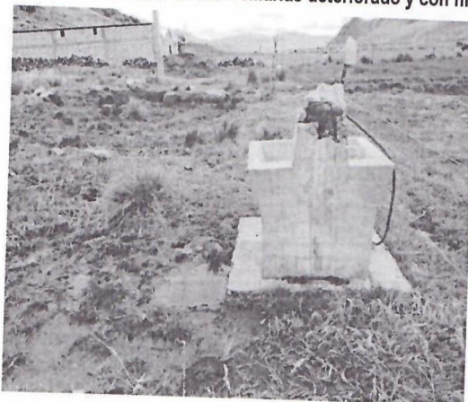
Ilustración N° 16: conexiones Domiciliarias deteriorado y con filtraciones
