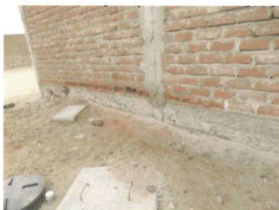
Foto N° 05: Deterioro de muro de ladrillo por presencia de salitre
