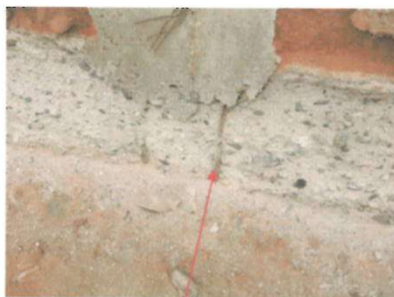
Foto N° 06: Acero de columna expuesto y oxidado
