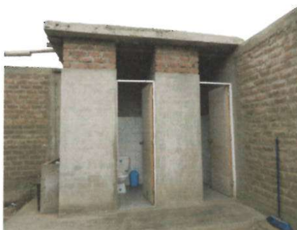
Foto N° 02: Servicios higiénicos sin columnas y vigas
