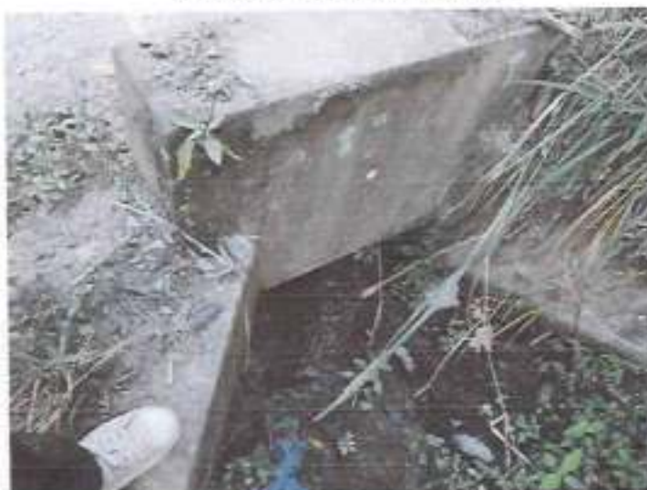
Alcantarillas acolmatadas y dañadas podrían ser un futuro problema para la plataforma
