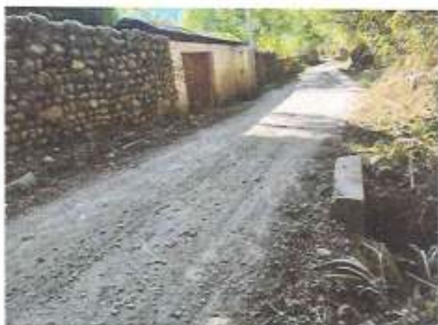
Foto N° 261 PROGRESIVA 40+445 DESCRIPCION Alcantarilla para limpiar
