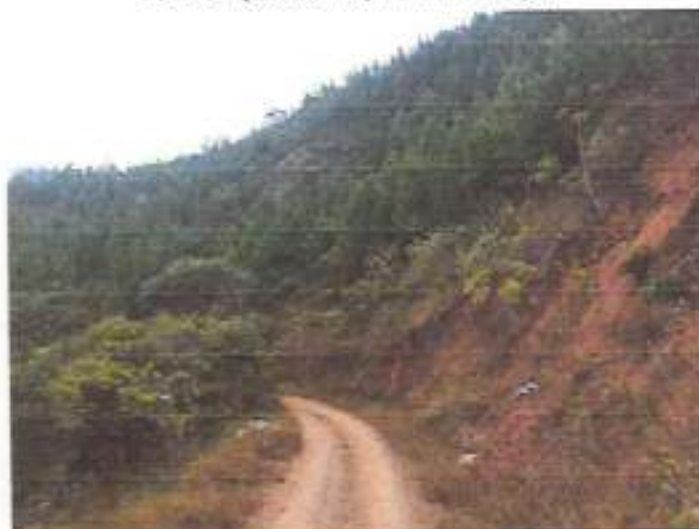
Talud empinado posible derrumbe.
