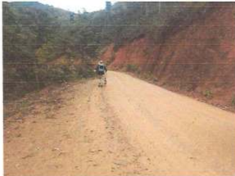
Talud demasiado empinado, posible lugar de derrumbes.
