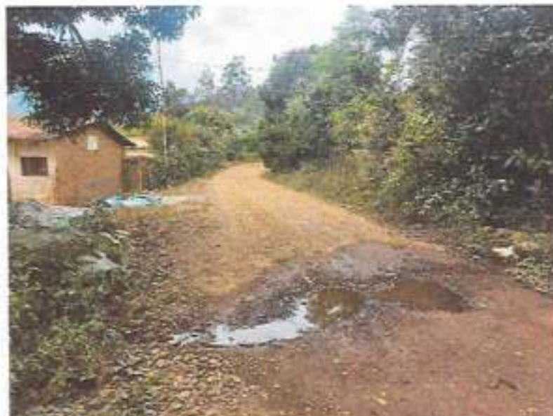
Cruce de Agua, necesita acción inmediata para que no dañe la plataforma.
