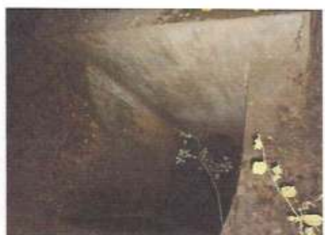
Foto N° 256 PROGRESIVA 39+880 DESCRIPCION Alcantarilla para limpiar
