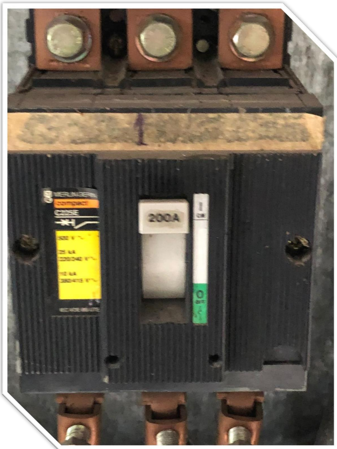
Fotografía N°1 : Interruptor general del tablero eléctrico.
