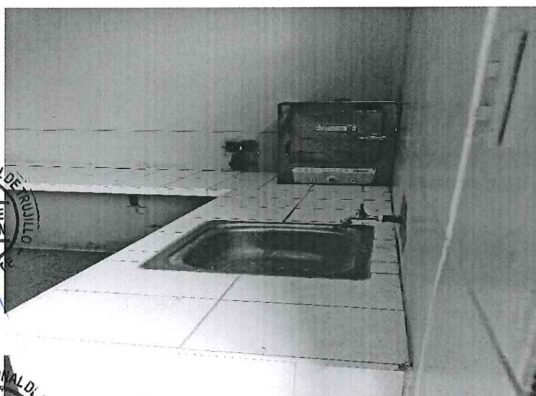
Foto N°05: Se observa el lavadero en mal estado y su llave desgastada por el uso.
