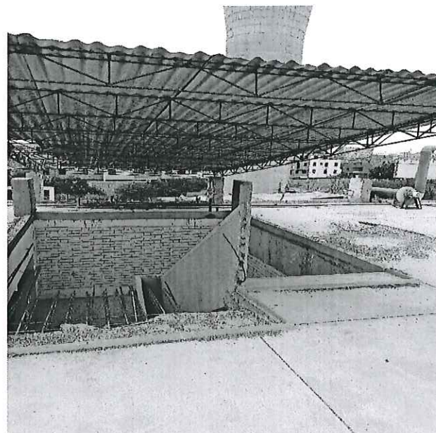
Foto N°12 - 13: Se observan las dos coberturas de acero corrugado en mal estado.
