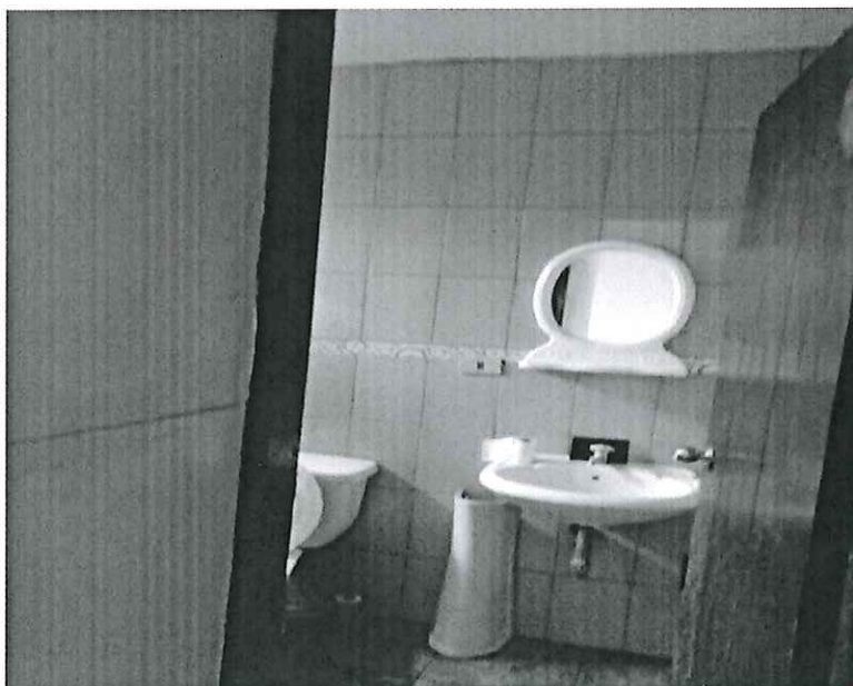
Foto N°03: Se observa los sanitarios en mal estado y clausurados por falta de mantenimiento, puertas rotas y despintadas.
