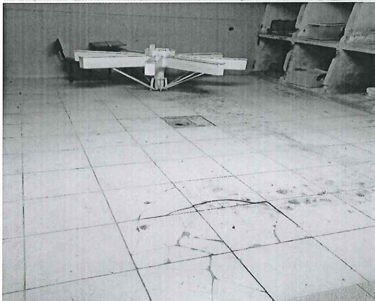
Foto N°02: Se observa el piso de porcelanato rajado, levantado y encajonado.
