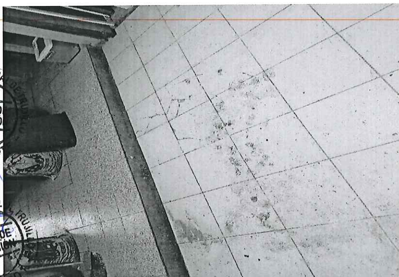
Foto N°08: Se observa que la cerámica se encuentra encajonada y en mal estado.
