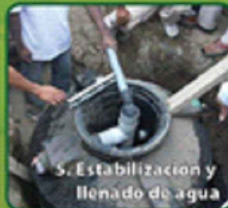
QUINTO PASO ESTABILIZACIÓN Y LLENADO DE AGUA
