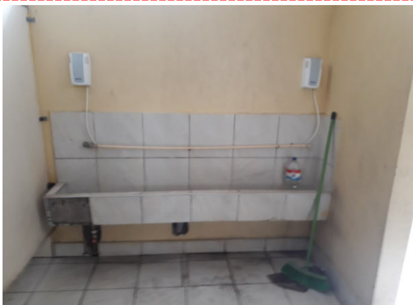
Fotografía 24: elevación 02 de los servicios higiénicos M7. Cubículos de duchas sin puertas. Una salida de cuha sin griferías. Enchapes en muros antiguos.
