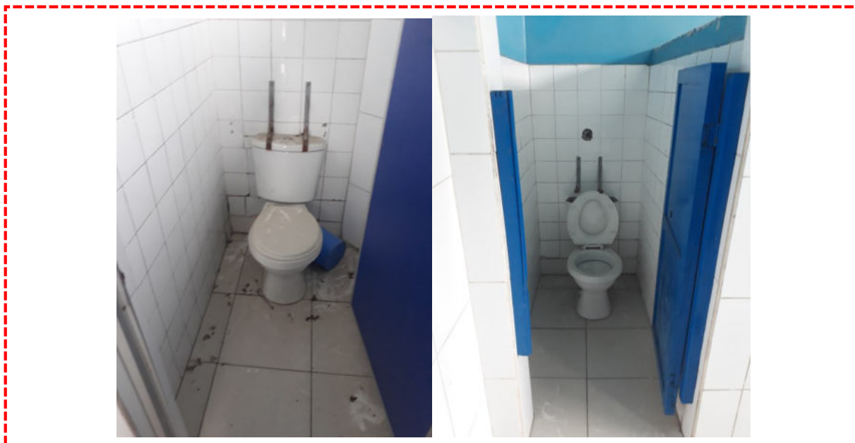
Fotografía 10: elevación 04 de los servicios higiénicos M2. Enchape interior de cubículos antiguos, con piezas parchadas, rotos, el formato es diferente al del resto del ambiente. Puertas de cubículos de madera y de melamina.
