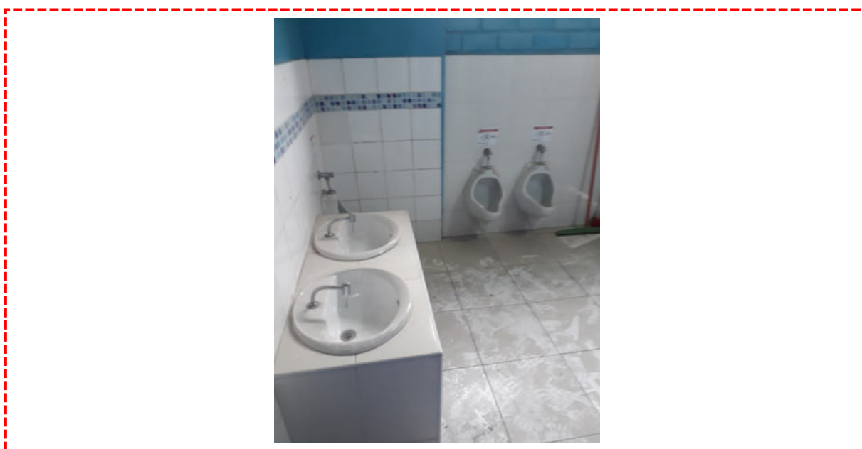
Fotografía 15: elevación 01 de los servicios higiénicos M3. Los urinarios que se visualizan no tienen la distancia adecuada de uso y no corresponden a aparatos para uso de niños de inicial. Enchape diferentes en el mismo ambiente.
