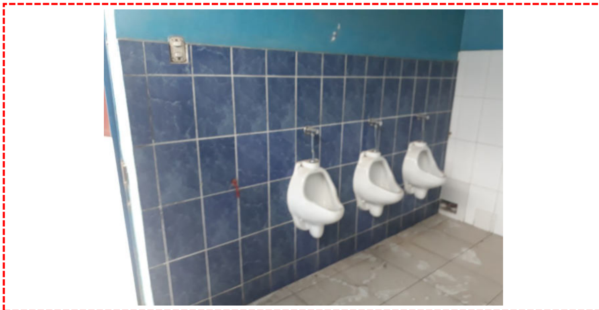
Fotografía 08: elevación 02 de los servicios higiénicos M2. Enchape en muros de dos colores y en alturas de instalación diferentes. Pisos enchapados en buen estado. Urinarios en buen estado de conservación. Interruptor instalado no se encuentra al ras de la superficie de enchape.
