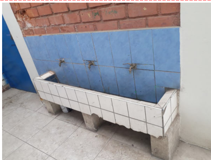
Fotografía 17: elevación 03 de los servicios higiénicos M3. Se visualiza un lavadero corrido para niños de nivel inicial, este se encuentra en mal estado, enchapes rotos, rajados y griferías con óxido.
