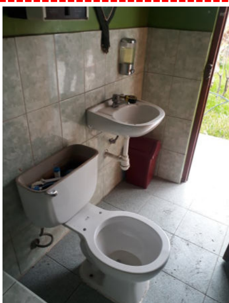
Fotografía 21: elevación 04 de los servicios higiénicos M5. Los enchapes en muros y pisos se encuentran en buen estado. Grifería en regular estado. Inodoro sin tapa en el tanque.
