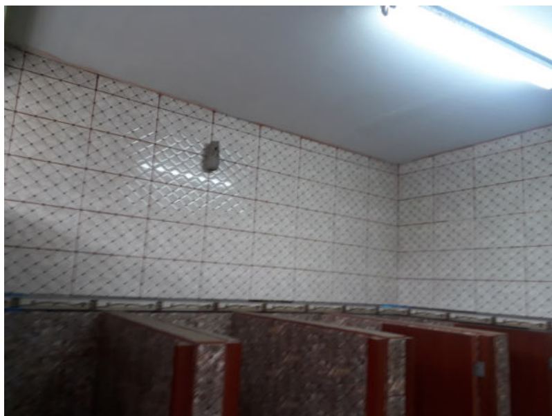
Fotografía 04: elevación 02 de los servicios higiénicos M1. Los enchapes de paredes y piso se encuentra en buen estado. Fluorescente en regular estado, no hermético por tanto, no es adecuado para un uso de baños.
