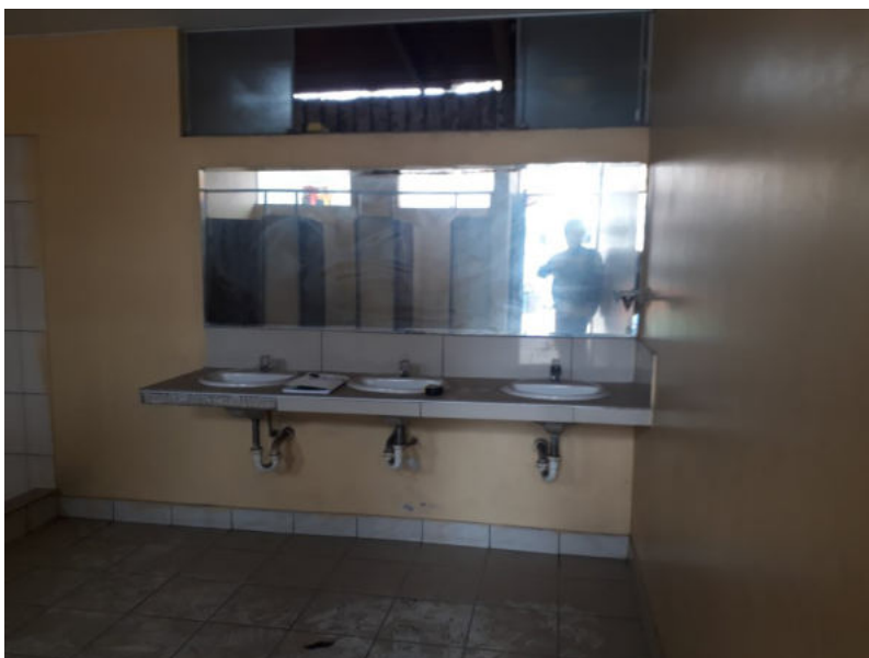
Fotografía 29: elevación 07 de los servicios higiénicos M6 , Se evidencia el deterioro en la pintura de las paredes y techo. Ventanas corredizas en buen estado. Enchape de lavadero con pieza desprendida y griferías en regular estado de conservación.
