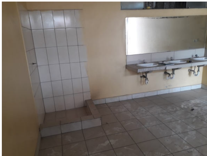
Fotografía 30: elevación 08 de los servicios higiénicos M6. Se visualiza una ducha sin cerramientos y sin griferías para su uso. Enchape en buen estado.
