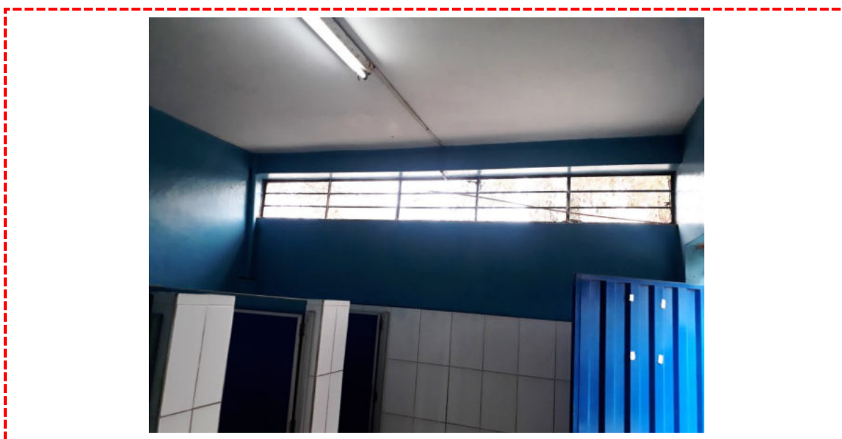
Fotografía 09: elevación 03 de los servicios higiénicos M2. Puerta metálica en buen estado de conservación. Ventanas altas con reja de protección despintadas, sin vidrios.
