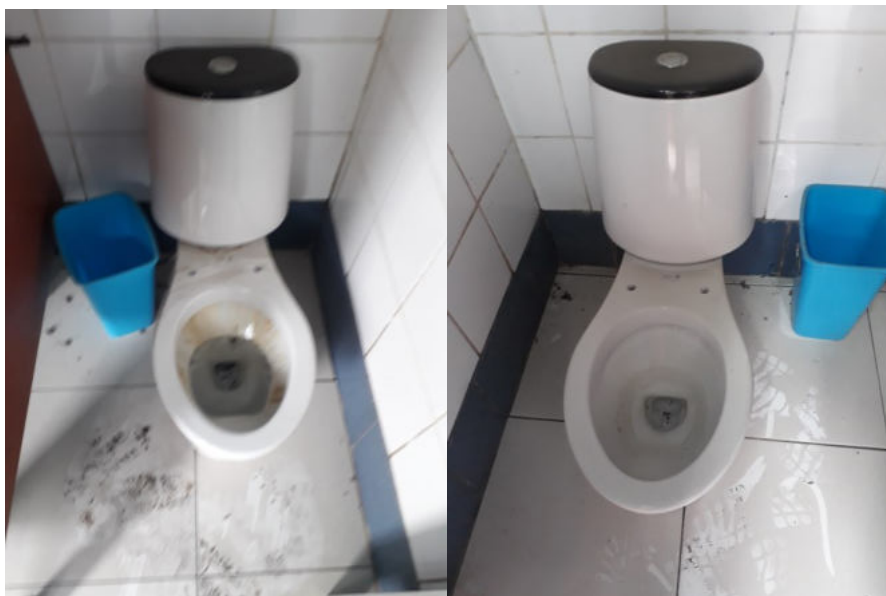
Fotografía 18: elevación 02 de los servicios higiénicos M3. Se visualiza que los inodoros no están correctamente colocados. Enchape en regular estado de conservación.
