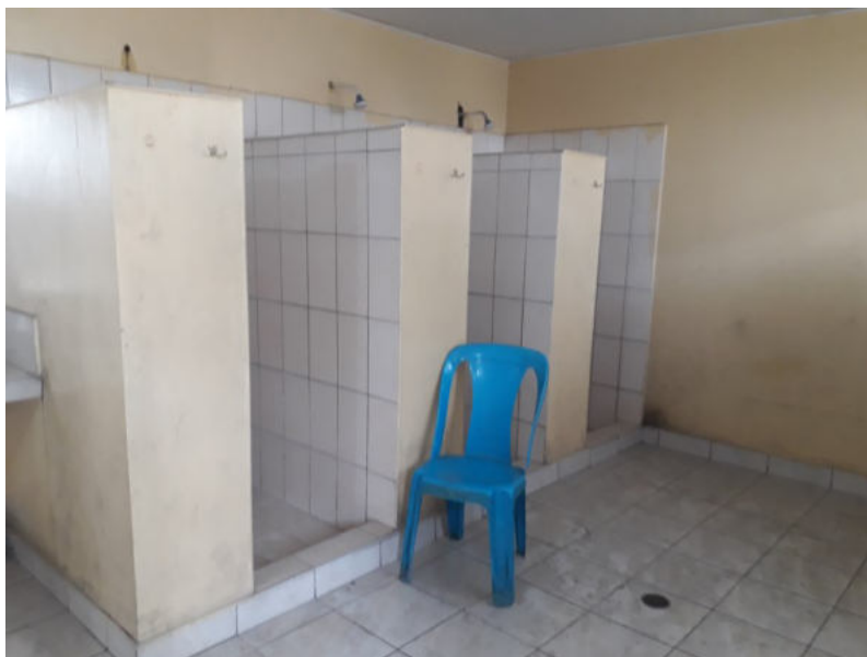
Fotografía 24: elevación 02 de los servicios higiénicos M7. Cubículos de duchas sin puertas. Una salida de cuha sin griferías. Enchapes en muros antiguos.
