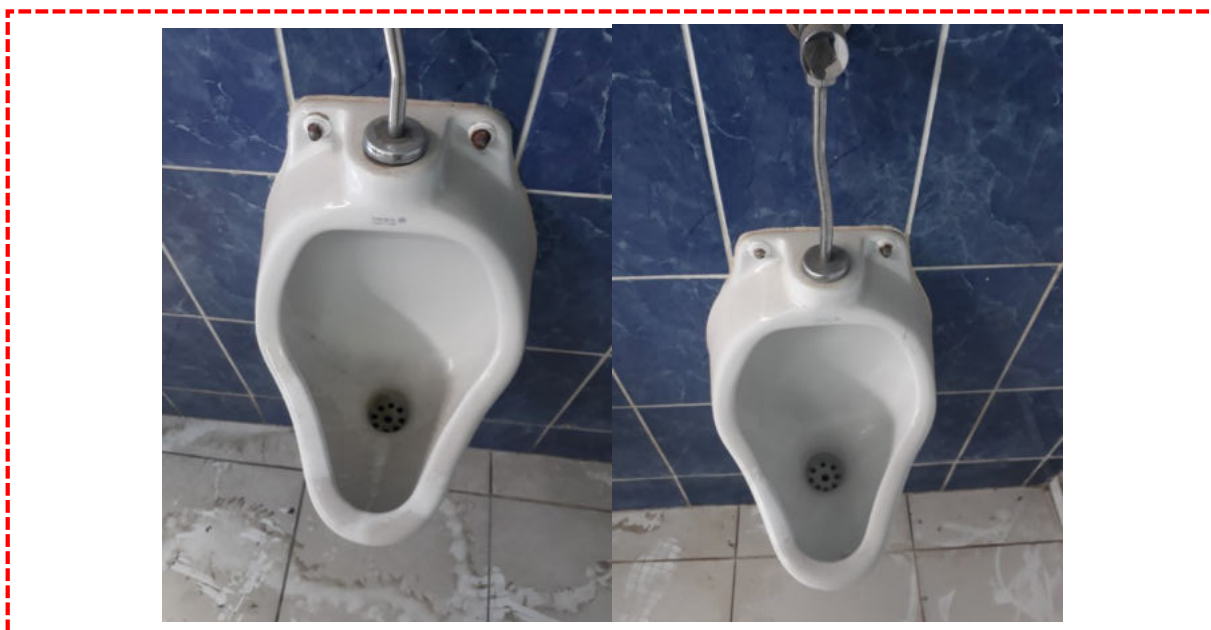
Fotografía 11: elevación 05 de los servicios higiénicos M2. Urinarios en buen estado de conservación, tornillos de fijación oxidados .
