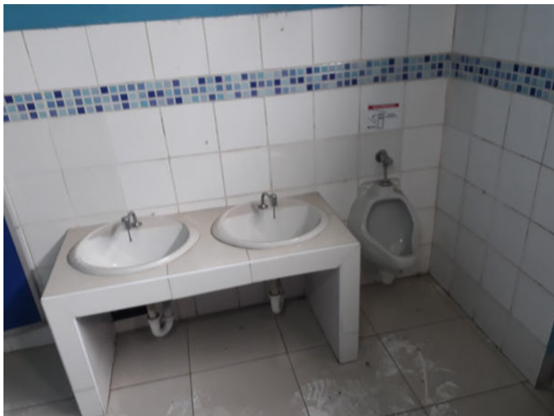
Fotografía 16: elevación 02 de los servicios higiénicos M3. El urinario se ha instalado cerca a los lavaderos, el espacio no es el suficiente para su uso.
