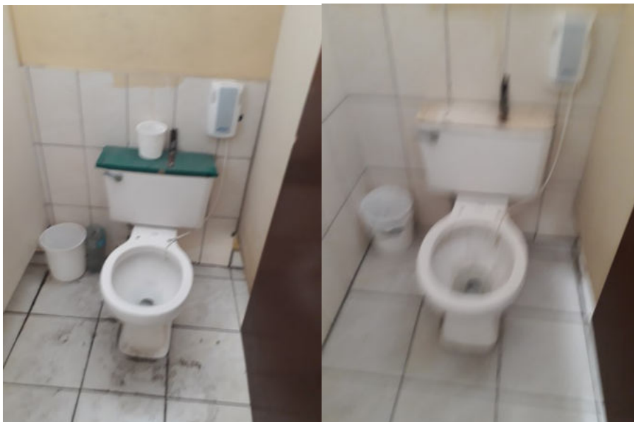
Fotografía 26: elevación 04 de los servicios higiénicos M7. Se evidencia el deterioro de los 02 inodoros, las tapas de los tanques son de madera. Enchape en muros antiguo.
