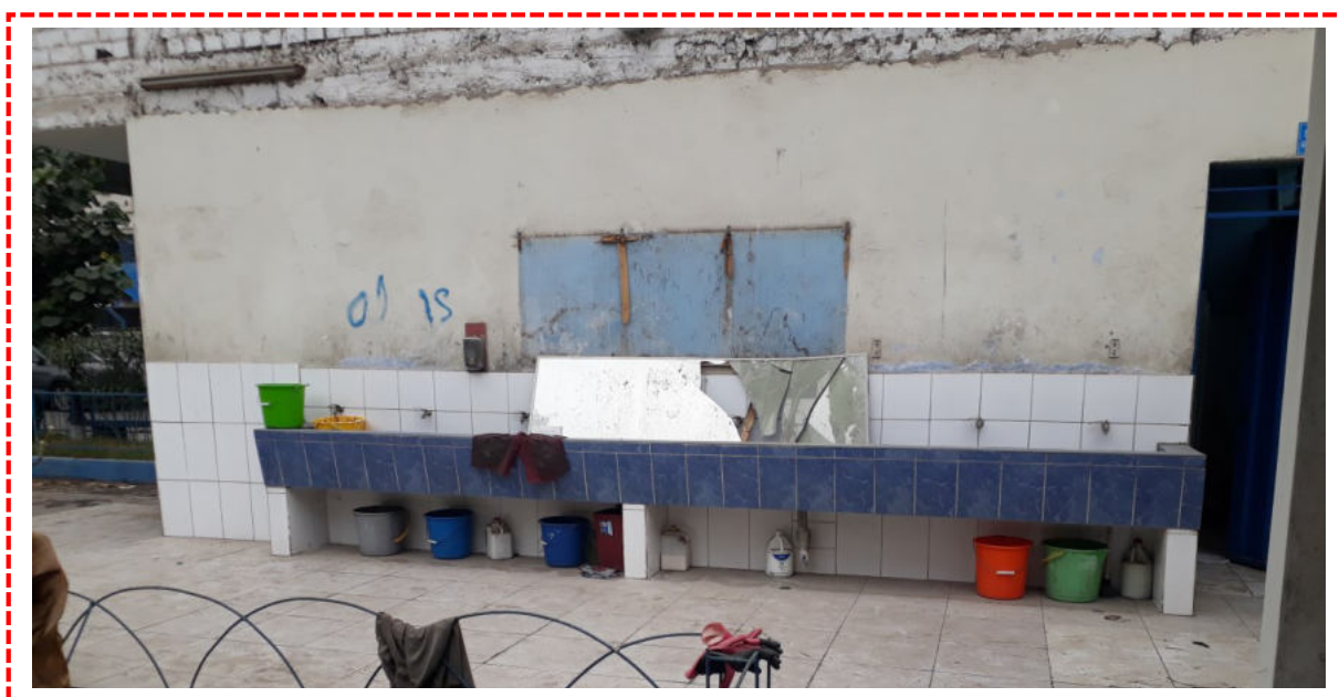
Fotografía 07: elevación 01 de los servicios higiénicos M2. Se evidencia el deterioro en la pintura de la pared, las 08 griferías están en mal estado. El lavadero se encuentra ubicado al ras de la puerta de ingreso, siendo un riesgo para la evacuación de los alumnos.
