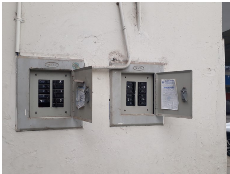
Fotografía 02: Derecha tablero general, izquierda tablero TD - 01
