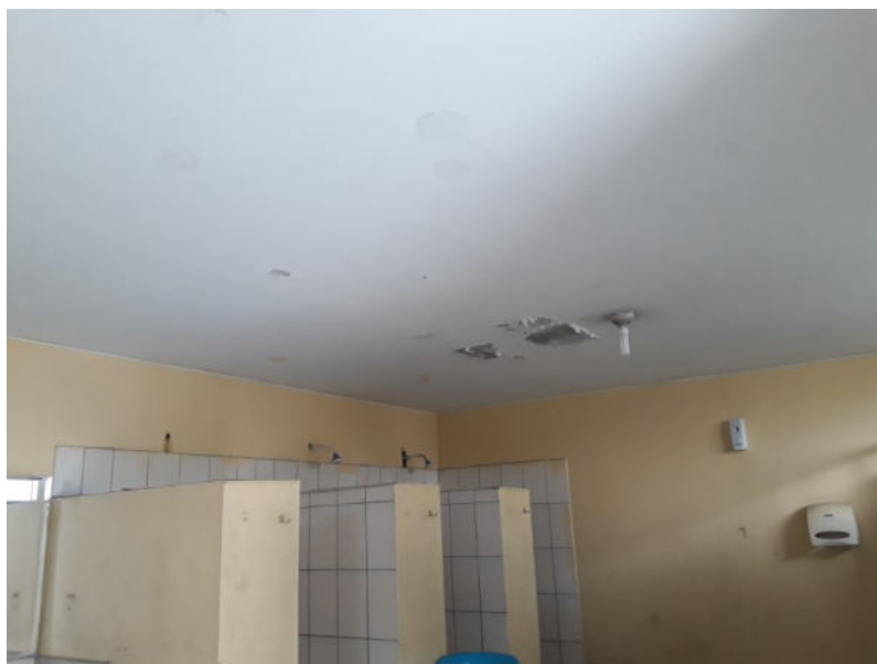
Fotografía 27: elevación 05 de los servicios higiénicos M7. Se evidencia el deterioro de la pintura en el cielo raso, con presencia de humedad. Pintura en regular estado, con manchas.
