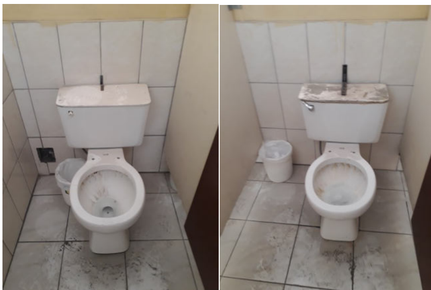
Fotografía 31: elevación 08 de los servicios higiénicos M6. Se evidencia el deterioro de los inodoros, se recomienda sus cambios, se debe implementar dispensador de papel higiénico y tapas en cada inodoro.
