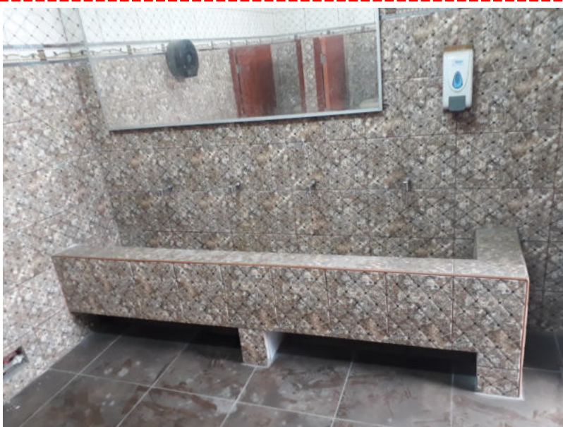
Fotografía 04: elevación 02 de los servicios higiénicos M1. Los enchapes de paredes y piso se encuentra en buen estado. Fluorescente en regular estado, no hermético por tanto, no es adecuado para un uso de baños.
