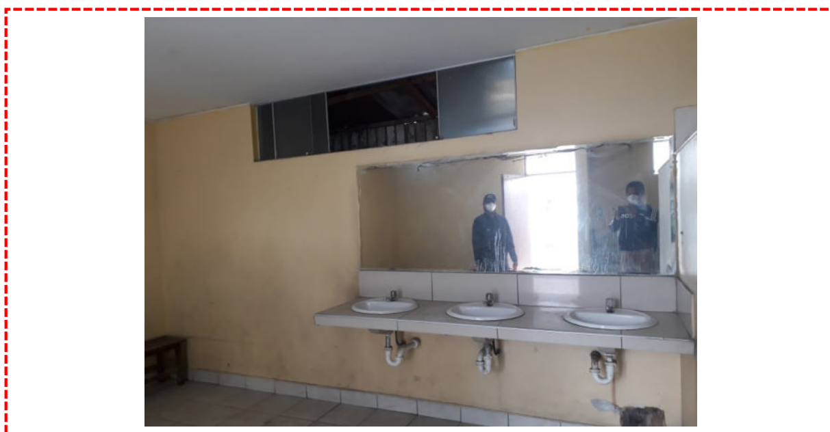
Fotografía 23: elevación 01 de los de los servicios higiénicos M7. Se evidencia el deterioro en la pintura de las paredes y techo. Las 03 griferías de los lavaderos se encuentran en regular estado.
