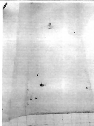
EL DETERIORO DE PINTURA EN MUROS -- POR PRESENCIA DE HUMEDAD
