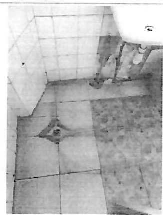
PIEZAS FALTANTES DE CERAMICO EN ZOCALO, PISO CON DISTINTO TIPO DE CERAMICO Y LA PRESENCIA DE SARRO.
