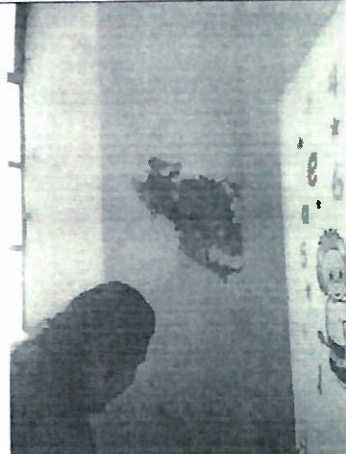
EL DESPRENDIMIENTO DE PINTURA DETERIORO DE TARRAJEO EN MUROS
