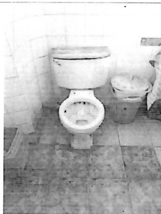
PIEZAS FALTANTES DE CERAMICO EN ZOCALO, PISO CON DISTINTO TIPO DE CERAMICO Y LA PRESENCIA DE SARRO.
