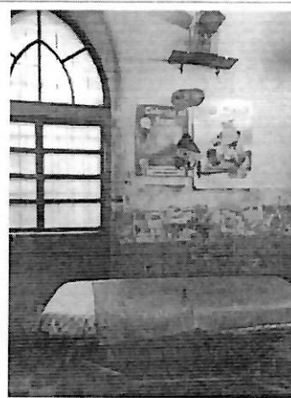
DETERIORO DE PINTURA Y DESPRENDIMIENTO DETARRAJEO DE PAREDES DE CONSULTORIOS
