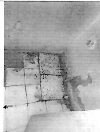
PIEZAS FALTANTES Y ROTAS DE CERAMICO EN ZOCALO, PISO CON DISTINTO TIPO DE CERAMICO Y LA PRESENCIA DE SARRO.
