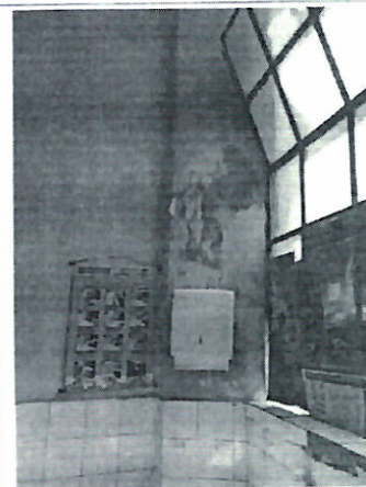
EL DESPRENDIMIENTO DE PINTURA DETERIORO DE TARRAJEO EN MUROS
