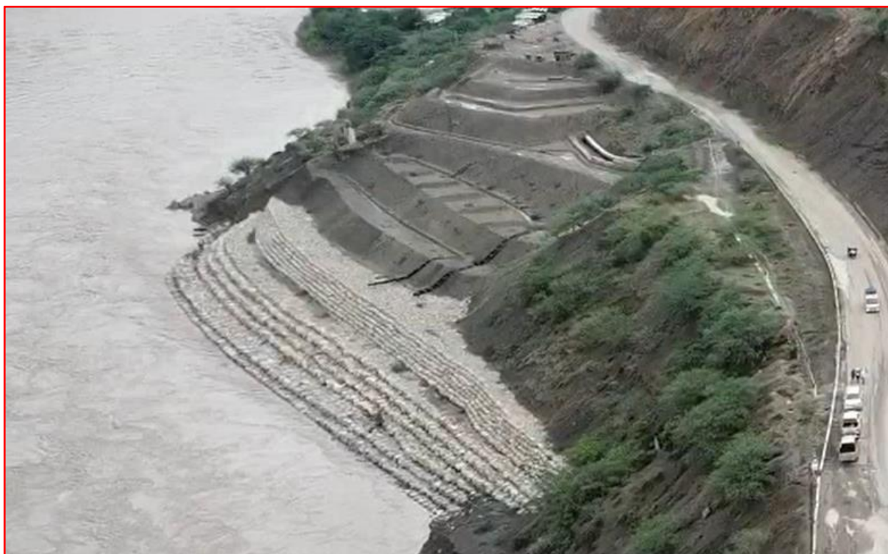
Fotografía N° 07.- Vista Panorámica del enrocado construido el 2017 por INMAC PERÚ SAC, así como la conformación de terrazas entre la corona del enrocado y la plataforma de la carretera
