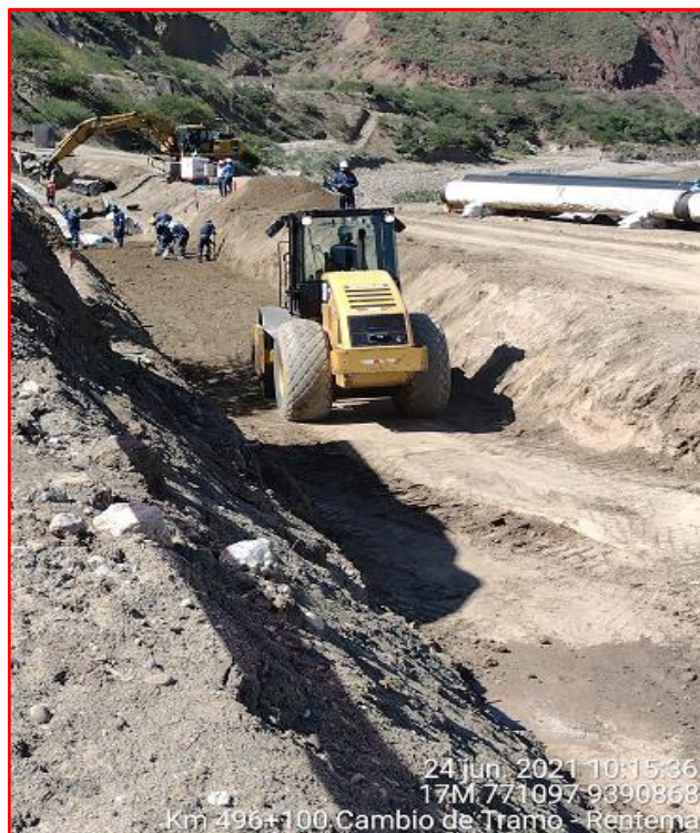
Fotografías N° 10 y 11.- Esparcido y compactación de relleno.
