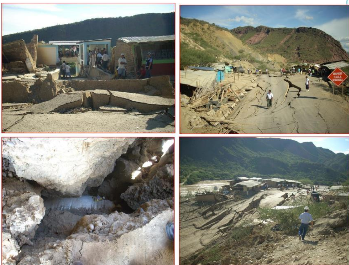
Fotografías N°s 01, 02, 03 y 04.- Efectos del deslizamiento del 28.03.2009, daños en viviendas y carretera, se muestra descubrimiento de tubería
