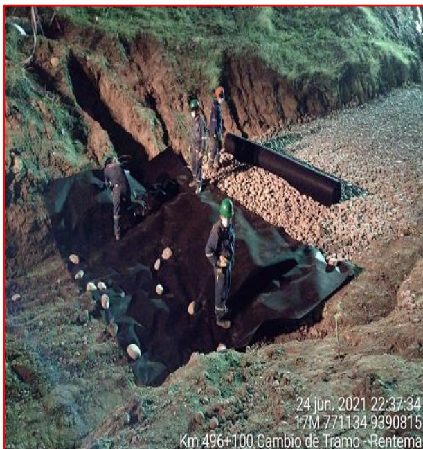
Fotografías N° 08 y 09.- Mejoramiento surasante con over.
