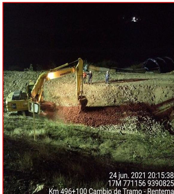
Fotografías N° 08 y 09.- Mejoramiento surasante con over.
