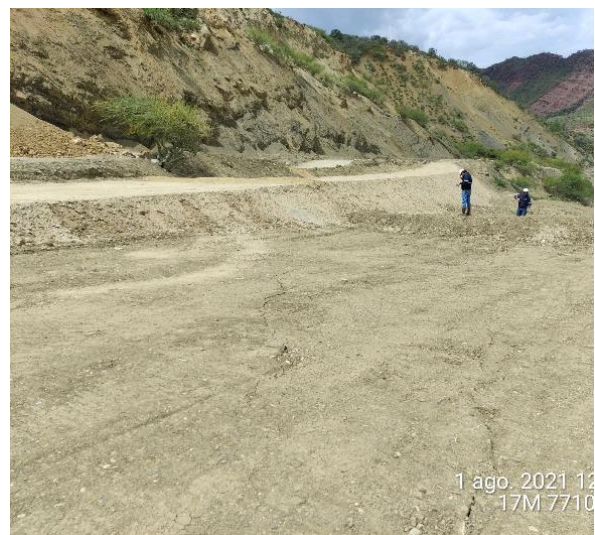
Fotografía N° 14.- Fisura en relleno controlado construido por BIDDLE INC SAC.
