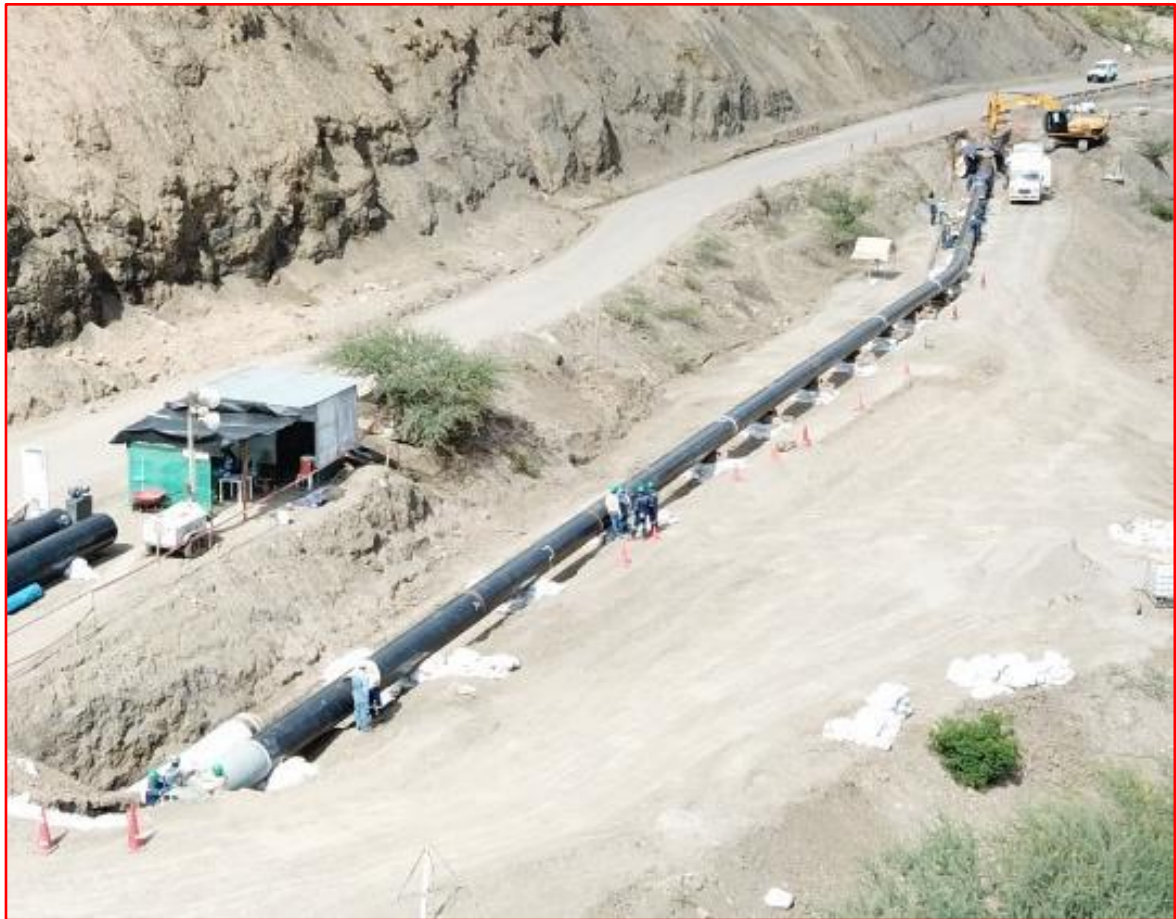
Fotografía N° 12.- Tubería de reemplazo (segmento) sobre relleno controlado.
