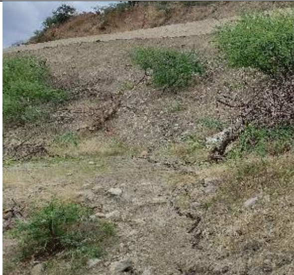
Fotografía N° 13.- Fisura en terrazas construidas por INMAC PERÚ SAC.
