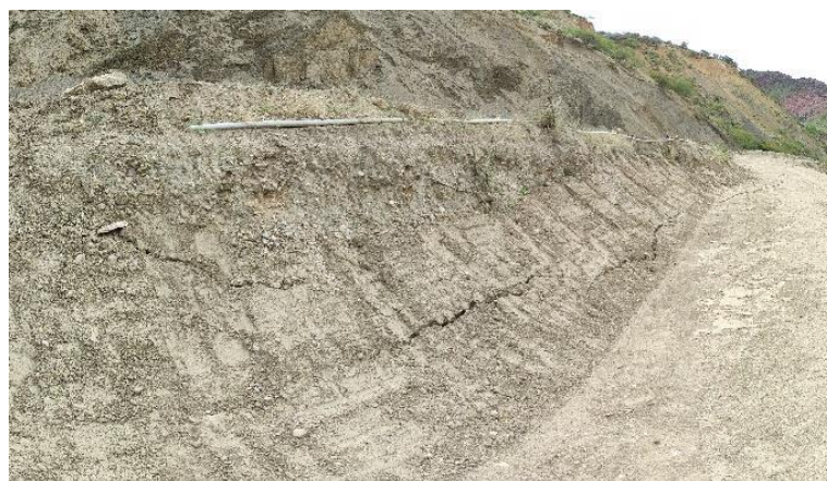
Fotografía N° 17.- Grietas en talud entre relleno controlado y carretera.
