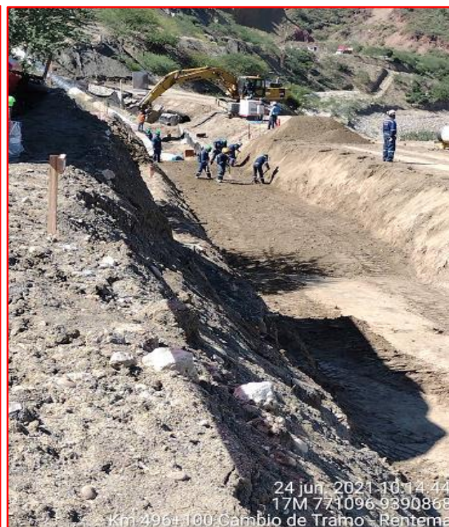
Fotografías N° 10 y 11.- Esparcido y compactación de relleno.
