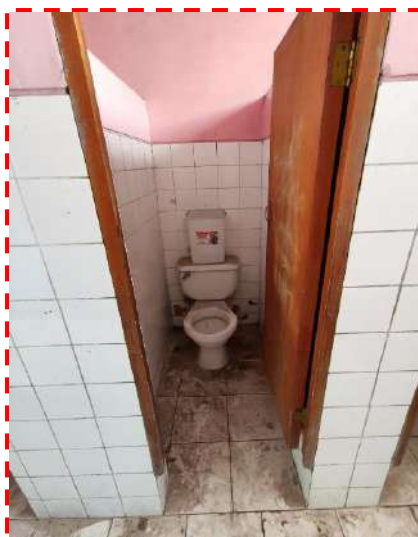
Fotografía 10: Servicios Higiénicos 01 (mujeres) – Cubículos de Inodoros Se evidencia el deterioro en los pisos / muros / equipamiento / accesorios / puertas
