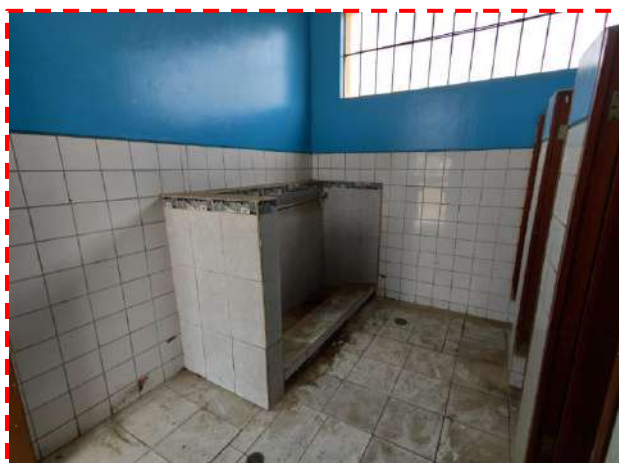
Fotografía 04: Servicios Higiénicos 01 (varones) – Urinario corrido en mal estado. Se evidencia el deterioro en los muros / equipamiento / accesorios / enchape de pared
