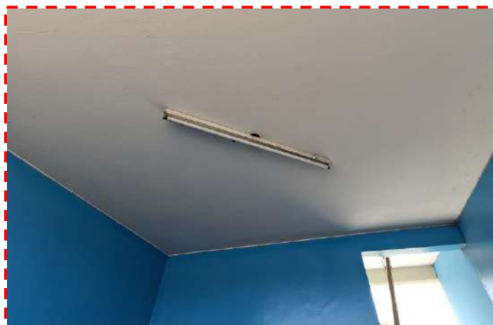
Fotografía 06: Cielo raso de los Servicios Higiénicos 01 (varones). Se evidencia el deterioro de pintura / tarrajeo / luminarias
