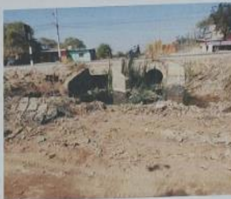
Foto 6. Alcantarilla Alcantarilla de concreto en buen estado
