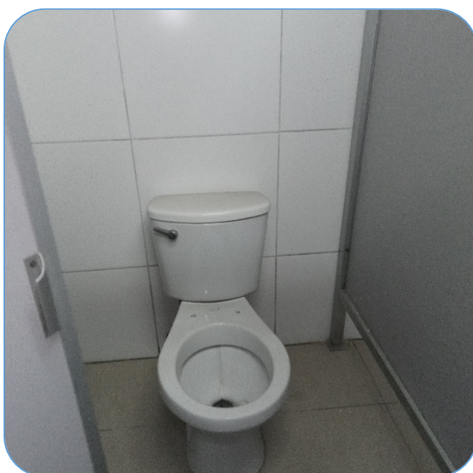
Fotografía N° 08.- Cambio de Inodoros y limpieza y desatoro de puntos de desagüe en SS.HH. Damas – 3er Piso.
