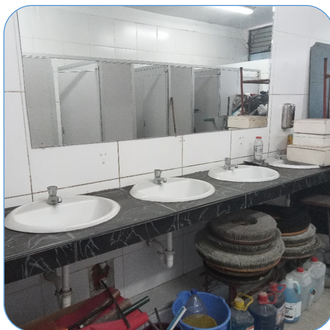
Fotografía N° 07.- Cambio de Ovalines y limpieza y desatoro de puntos de desagüe en SS.HH. Damas – 3er Piso.
