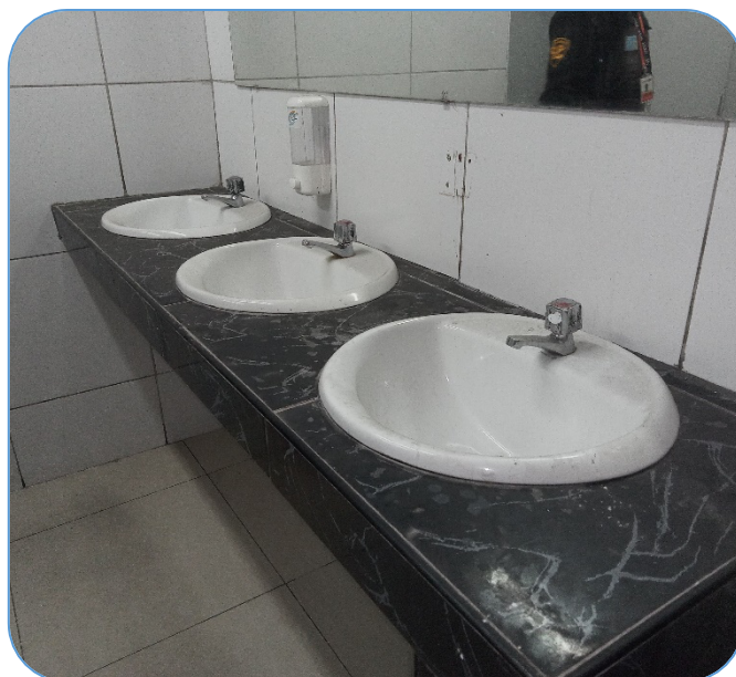
Fotografía N° 05.- Cambio de Ovalines y limpieza y desatoro de puntos de desagüe en SS.HH. Alumnos Varones – 3er Piso.
