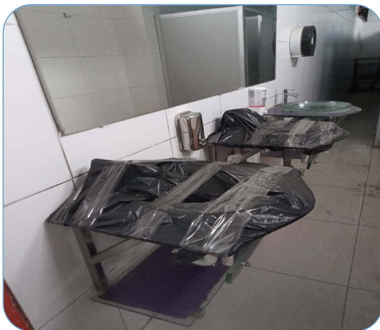
Fotografía N° 03.- Cambio de Ovalines de Vidrio y limpieza y desatoro de puntos de desagüe en SS.HH. Docentes Damas.
