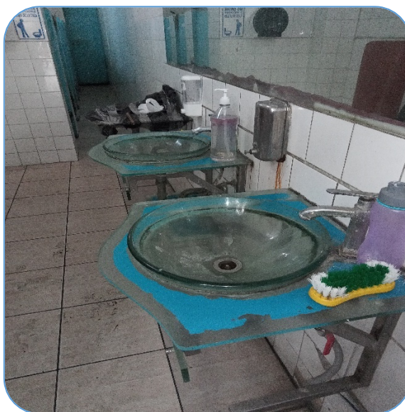
Fotografía N°01.- Cambio de Ovalines de Vidrio y limpieza y desatoro de puntos de desagüe en SS.HH. Docentes Varones.
