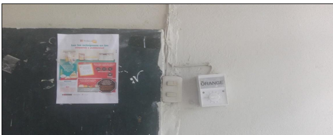
Foto N° 05: Se contempla una foto interior del pabellón 02. Las instalaciones electricas se encuentran expuestas, es decir no se encuentran empotradas ni canalizadas; por lo tanto representan un riesgo para los estudiantes.
