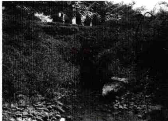
En esta toma se puede apreciar la colmatación y el mal estado en que se encuentra la alcantarilla.
