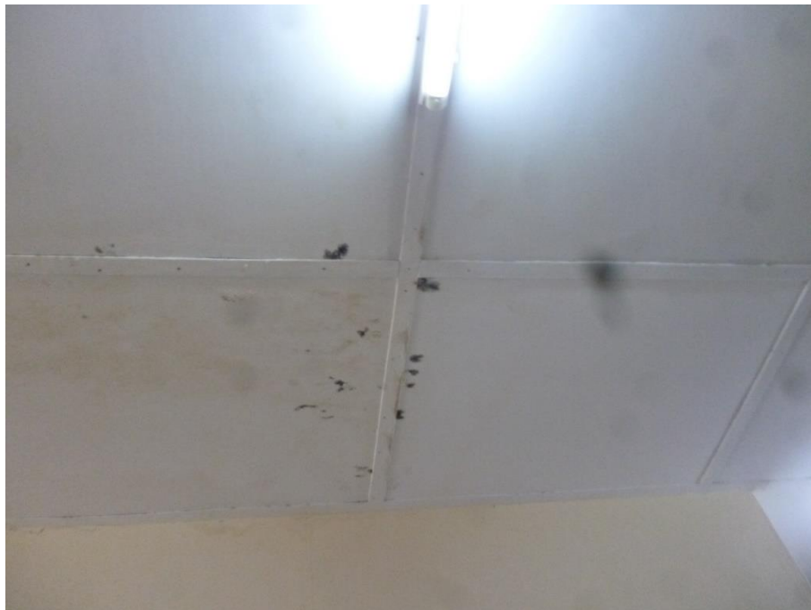
VISTA DEL CIELO RASO CON MANCHAS DE HUMEDECIMIENTO POR EFECTO DE GOTERAS
