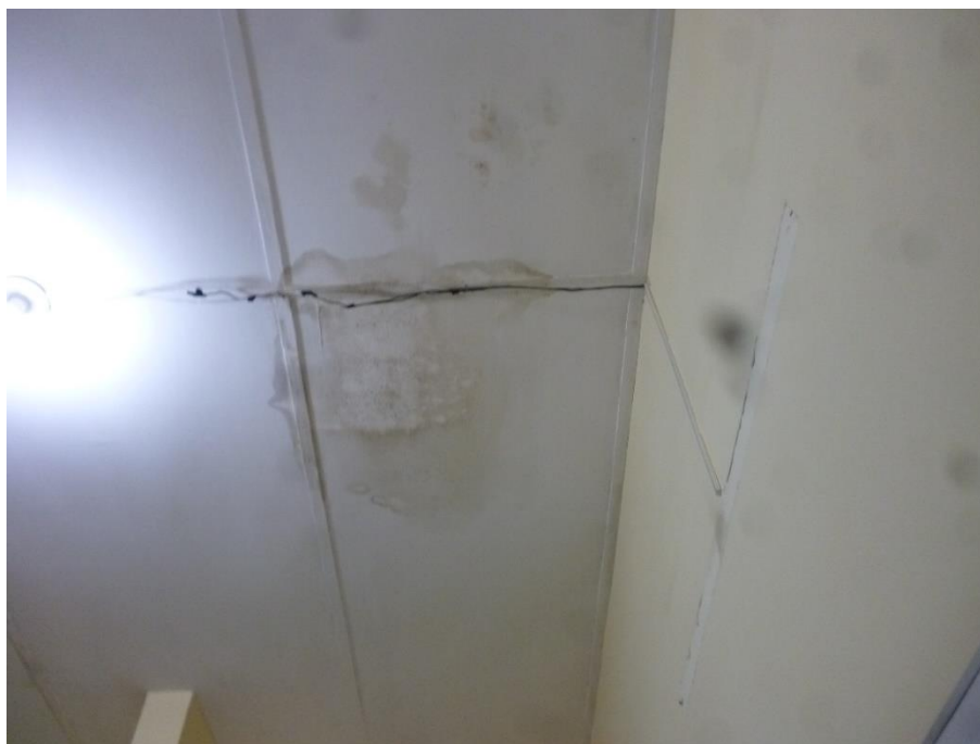
VISTA DE INTERIOR DEL CIELO RASO EN AMBIENTE DE MESA DE PARTES, CABLE EXPUESTO Y CIELO RASO HONGUEADO
