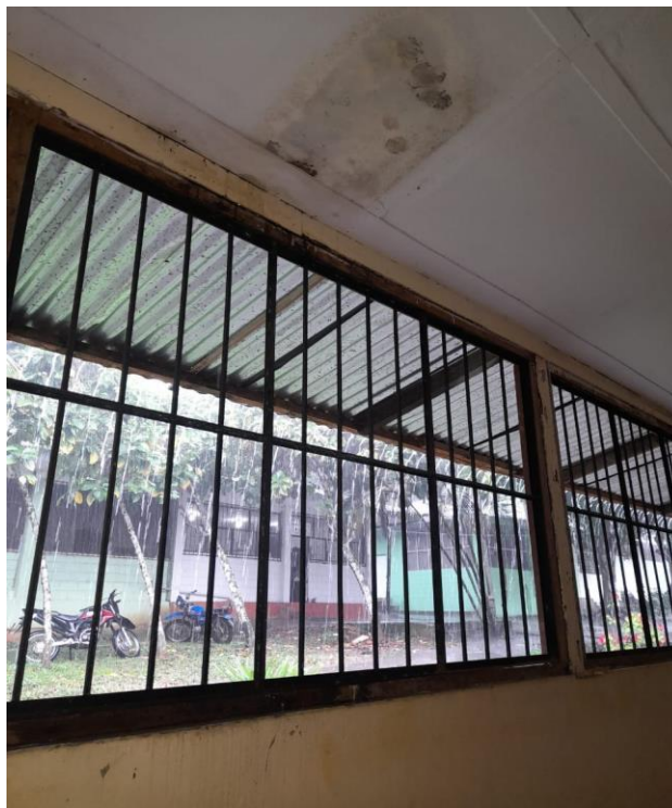
VISTA DEL INTERIOR DE PASADIZO CIELO RASO AVERIADO POR HUMEDAD
