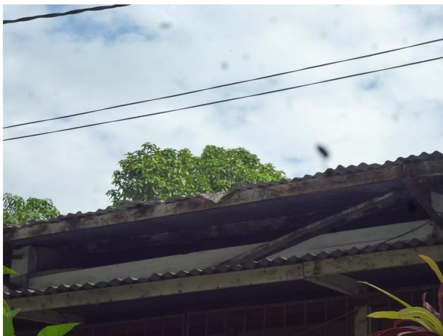
VISTA DEL ESTADO DE LA COBERTURA PRINCIPAL Y SOBLETECHO EN DETERIORO
