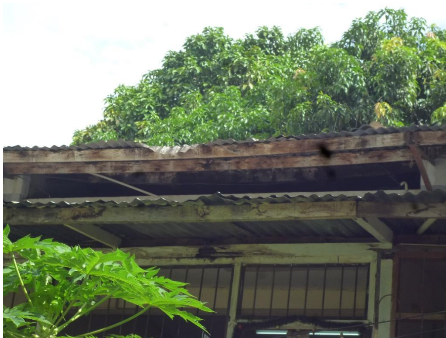
VISTA DEL ESTADO QUE PRESENTA EL MADERAJE QUE SOPORTA LA COBERTURA
