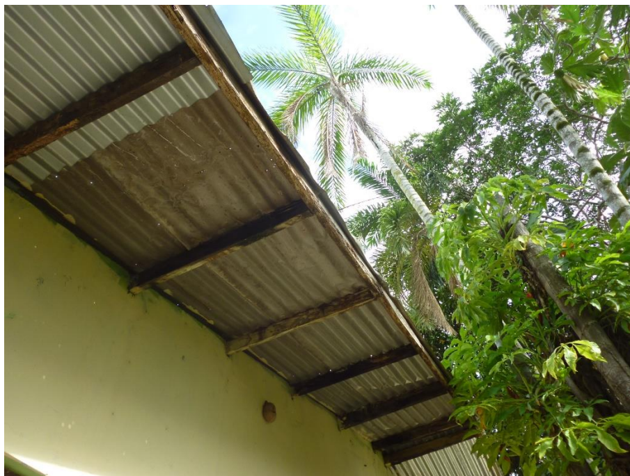
CORREAS DE MADERA EN SOBLETECHO DE COLA DE PATO HUMEDAS Y AVERIADAS
