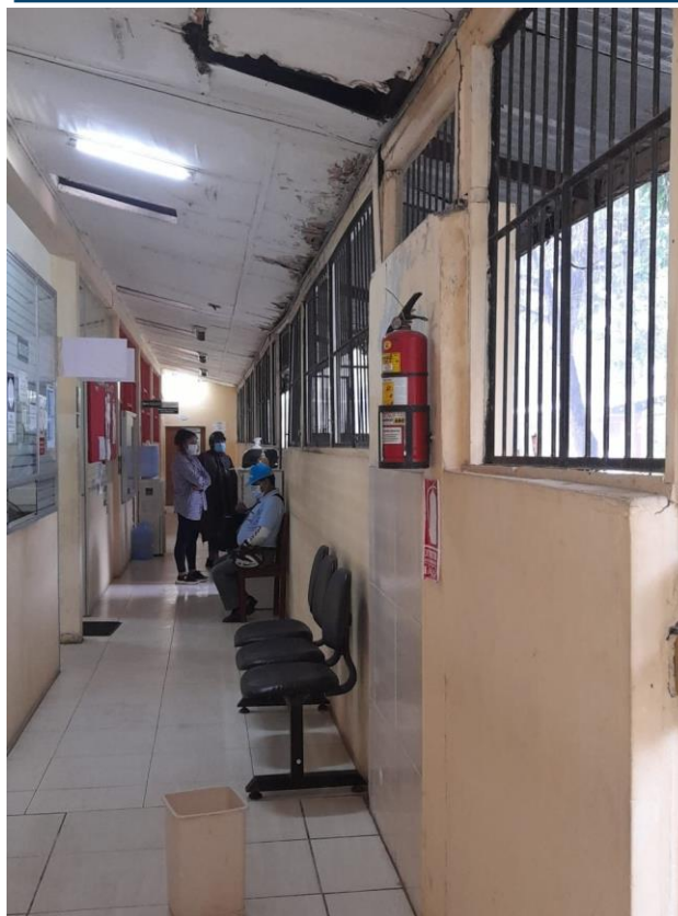
VISTA DEL INTERIOR DE PASADIZO CIELO RASO AVERIADO POR HUMEDAD
