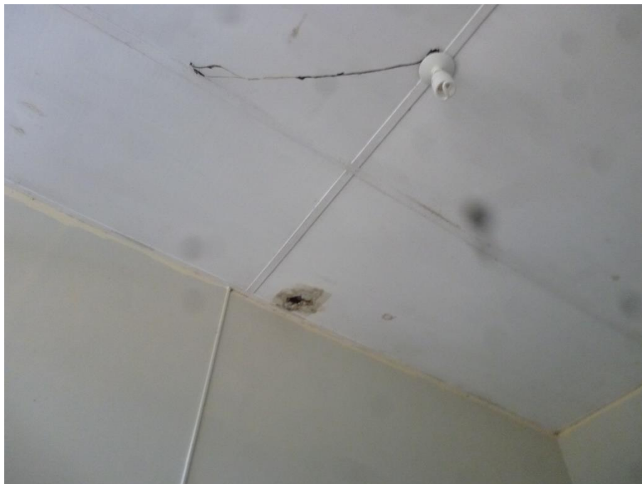
VISTA DE CENTRO DE LUZ CON LUMINARIA QUEMADA Y CABLE EXPUESTO, CIELO RASO PICADO
