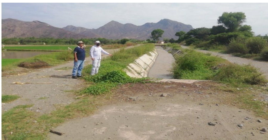
TRAMO DE 160 M DE CANAL REVESTIDO AGUAS ARRIBA DEL CONDUCTO CUBIERTO.
