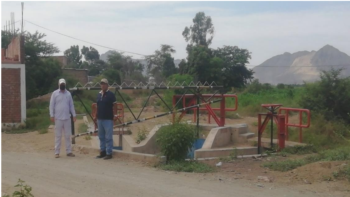
ESTRUCTURA REPARTIDORA TRES COMPUERTAS AL FINAL DEL CANAL PAMPAGRANDE.
