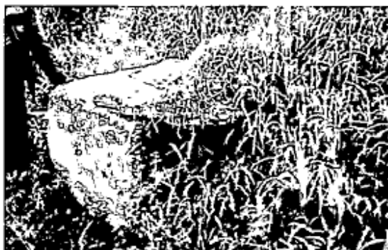
IMAGEN N° 7: Cámaras rompe Presión – Chir Chir
