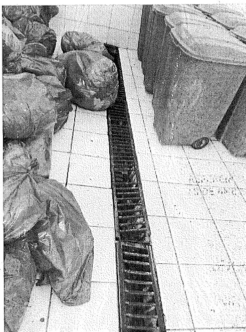
Foto No. 01 : Vista de la canaleta totalmente deteriorada y con atoro de la red de desagüe.
