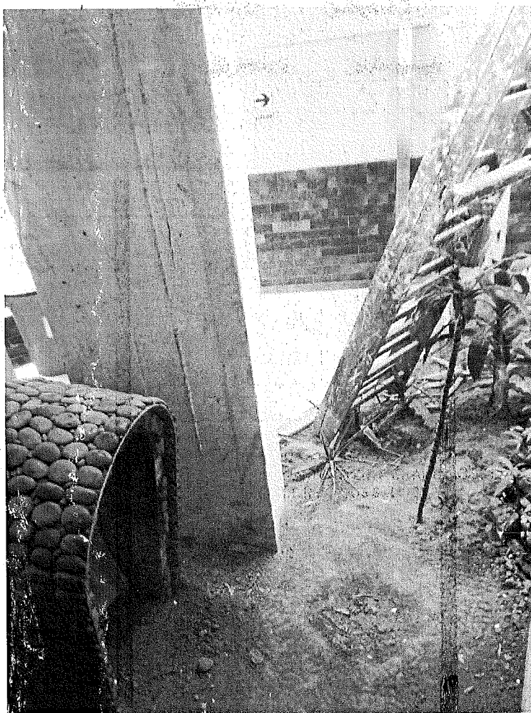
Foto No. 02 : Vista del actual almacenamiento intermedio de residuos frente al servicio de Consulta Externa , carece de piso , no tiene puertas , ni señalización, esta expuesto a contaminación , carece de materiales lavables, no tiene registros ni sumideros.
