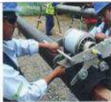
Imagen 2: Encintado con máquina
