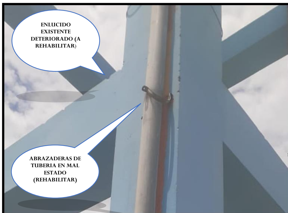
FOTOGRAFÍA N° 10: Reservorio elevado se deja notar el ingreso y bajada del agua, así mismo se muestra la escalera gato existente lo cual no presta seguridad al operador del sistema poniendo en riesgo la vida humana.
