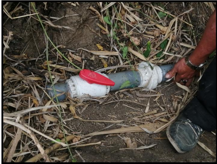
FOTOGRAFIA N° 12: En esta imagen se puede apreciar válvula de control Ø=2", no cuenta con estructura de concreto.
