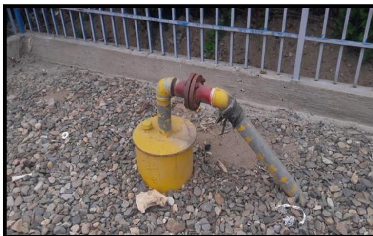
FOTOGRAFÍA N° 02: En esta imagen se puede apreciar tapa metálica pintada, presenta oxido por partes y doblada en los filos.
