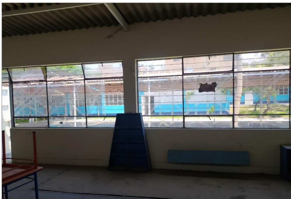
Gráfico N° 16: Otra vista interior del Pabellón 4, se visualiza el estado de las ventanas, los perfiles de las ventanas se encuentran oxidadas y en mal estado.
