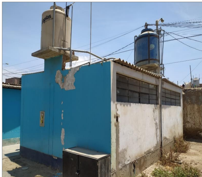
Gráfico N° 21: Otra vista del módulo de S.S.H.H., se visualizan dos tanques elevados en malas condiciones.
