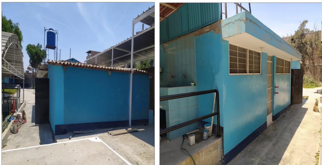
Gráfico N° 17: Vista del Pabellón de almacén y Qaliwarma, se observa el techo de calamina y portón metálico en mal estado. Se observa el tanque elevado sobre una estructura provisional encima de este pabellón.
