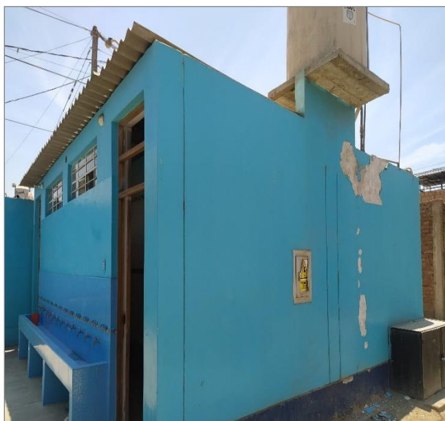
Gráfico N° 21: Otra vista del módulo de S.S.H.H., se visualizan dos tanques elevados en malas condiciones.
