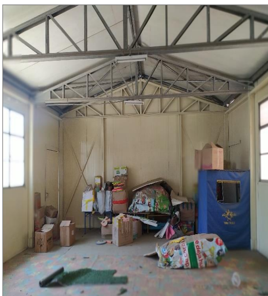
Gráfico N°12 y N° 13: Vista interior del pabellón 2, el cual es de material pre fabricado. Se visualiza el mal estado de este pabellón.
