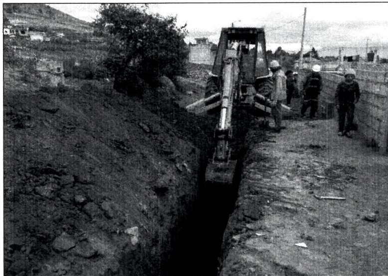
Imagen Referencial: EXCAVACION DE ZANJAS PARA TENDIDO DE TUBERIAS DE DESAGUE
