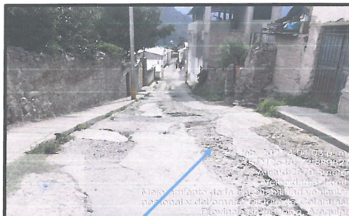
FALLA TOTAL DEL PAVIMENTO RIGIDO
