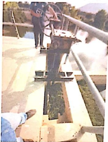
Foto N°07: Compuerta N° 01 barraje móvil inoperativo por falta de mantenimiento
