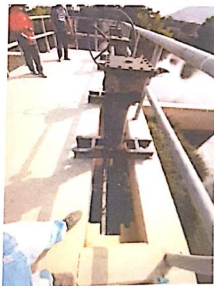
Foto N°08: Compuerta N° 03 Barraje móvil inoperativo por tener el vástago torcido y la falta de mantenimiento.
