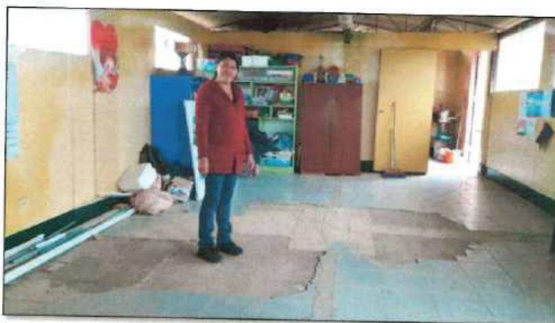
FOTO N° 02: VISTA LATERAL E INTERIOR DEL PABELLON, TIPO CONTAINER, SE OBSERVA RAJADURA EN LOS PISOS DE CONCRETO.
