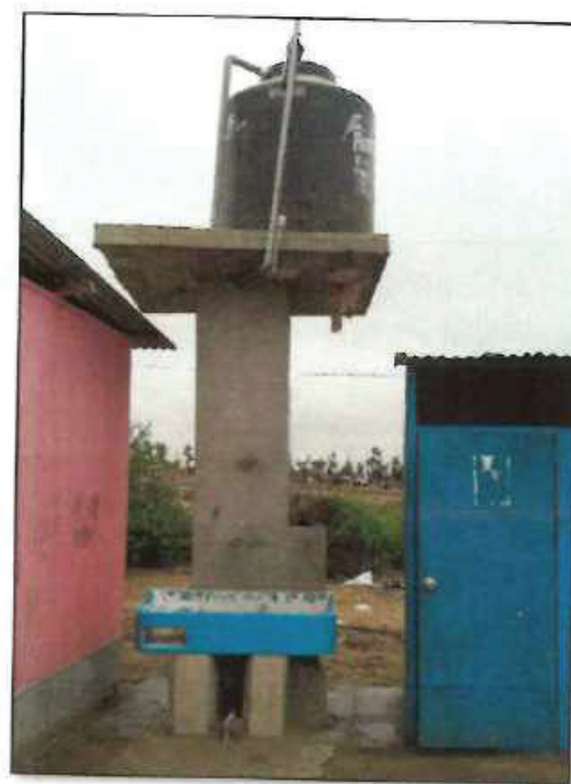
FOTO N° 06: VISTA FRONTAL DE LOS SS.HH. CONSTRUIDOS CON PRESUPUESTO DE MANTENIMIENTO, A LADO IZQUIERDO EL BIODIGESTOR Y TANQUE SEPTICO Y POR LA DERECHA EL TANQUE ELEVADO Y UN LAVADERO ACONDICIONADO.
