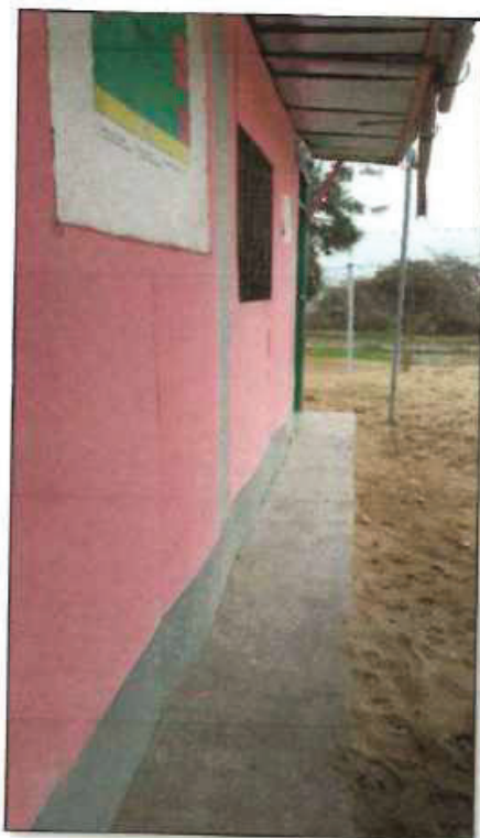
FOTO N° 04: VISTA LATERAL-POSTERIOR DEL PABELLÓN, SE OBSERVA UN LEVE ASENTAMIENTO DE LA LOSA DE BASE DE LA CONSTRUCCIÓN RURAL.
