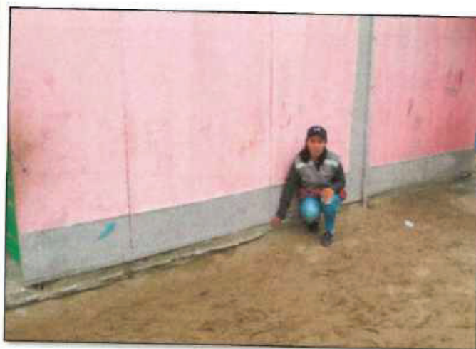
FOTO N° 04: VISTA LATERAL-POSTERIOR DEL PABELLÓN, SE OBSERVA UN LEVE ASENTAMIENTO DE LA LOSA DE BASE DE LA CONSTRUCCIÓN RURAL.
