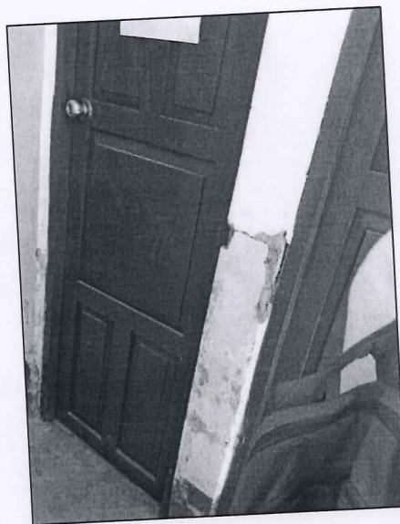
FOTO 04 – En la imagen se puede apreciar el mal estado de los muros y las puertas.
