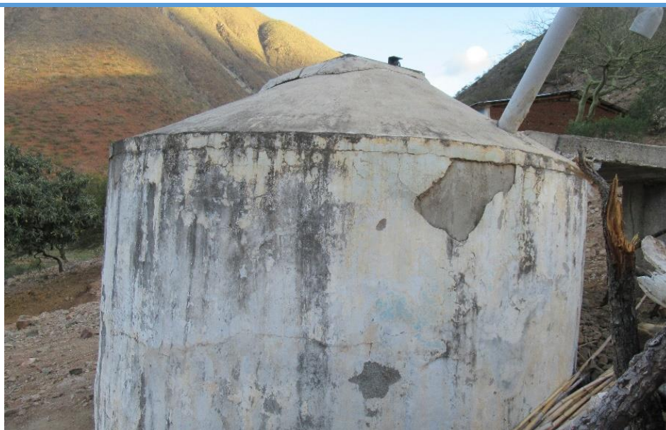
FOTO N°14: Vista panorámica de la estructura Reservorio Vol.=10.00m 3 del Sistema de Agua Existente, que se encuentra socavado, fisurado; daños ocasionados por las máximas avenidas, huaycos y derrumbes producidos por el Fenómeno del Niño Costero del 2017 (FEN 2017) . Requiere de manera urgente una rehabilitación.
