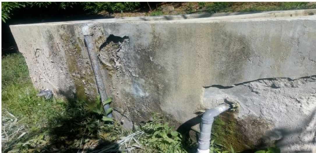
FOTO N°11: Vista del Sedimentador del Sistema de Agua Existente, mismo que se encuentra deteriorado y fisurado; daños ocasionados por las máximas avenidas, huaycos y derrumbes del Fenómeno del Niño Costero del 2017 (FEN 2017) .
