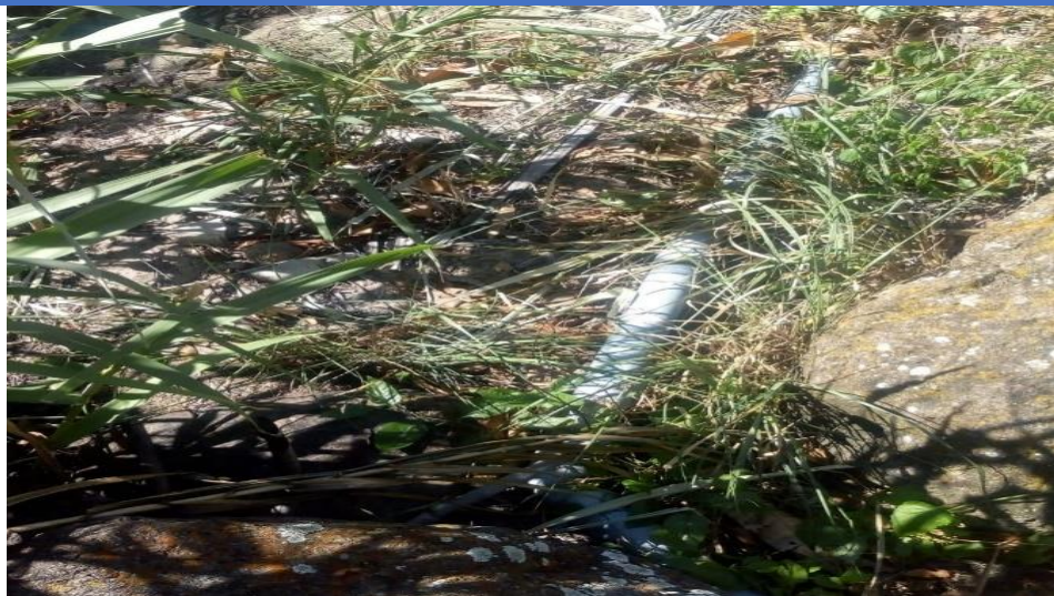
FOTO N°04: Vista Panorámica de la Línea de conducción del SAP existente Progr. 0+400, misma que se encuentra afectada, colmatada, deteriorada y expuesta a la intemperie; por los daños ocasionados por el Fenómeno del Niño Costero (FEN 2017) .
