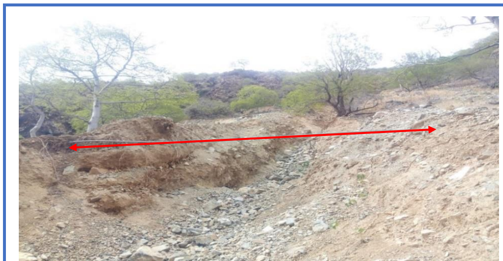
FOTO N°12: Vista Panorámica del pase aéreo de la Línea de Conducción del SAP existente, misma que se encuentra colapsada y expuesta a la intemperie, y con daños ocasionados por el Fenómeno del Niño Costero (FEN 2017) , reparada rústicamente y sin ningún criterio técnico por los pobladores con la finalidad de contar con este líquido elemento.
