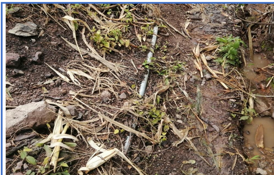
FOTO N°03: Vista Panorámica de la Línea de conducción del SAP existente Progr. 0+200, misma que se encuentra afectada, colmatada, deteriorada y expuesta a la intemperie; por los daños ocasionados por el Fenómeno del Niño Costero (FEN 2017) .
