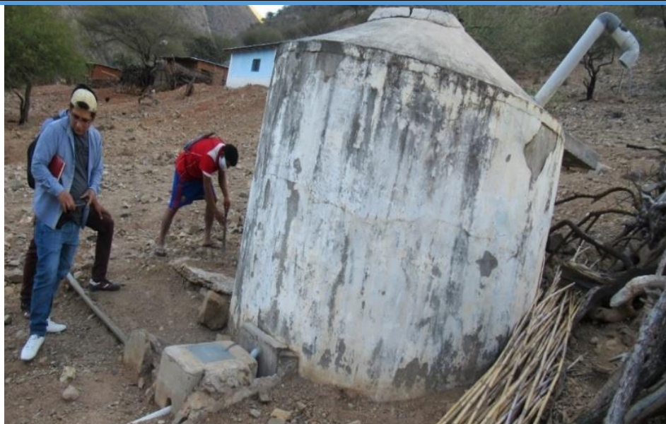
FOTO N°13: Vista panorámica de la estructura Reservorio Vol.=10.00m 3 del Sistema de Agua Existente, que se encuentra socavado, fisurado; daños ocasionados por las máximas avenidas, huaycos y derrumbes producidos por el Fenómeno del Niño Costero del 2017 (FEN 2017) . Requiere de manera urgente una rehabilitación.
