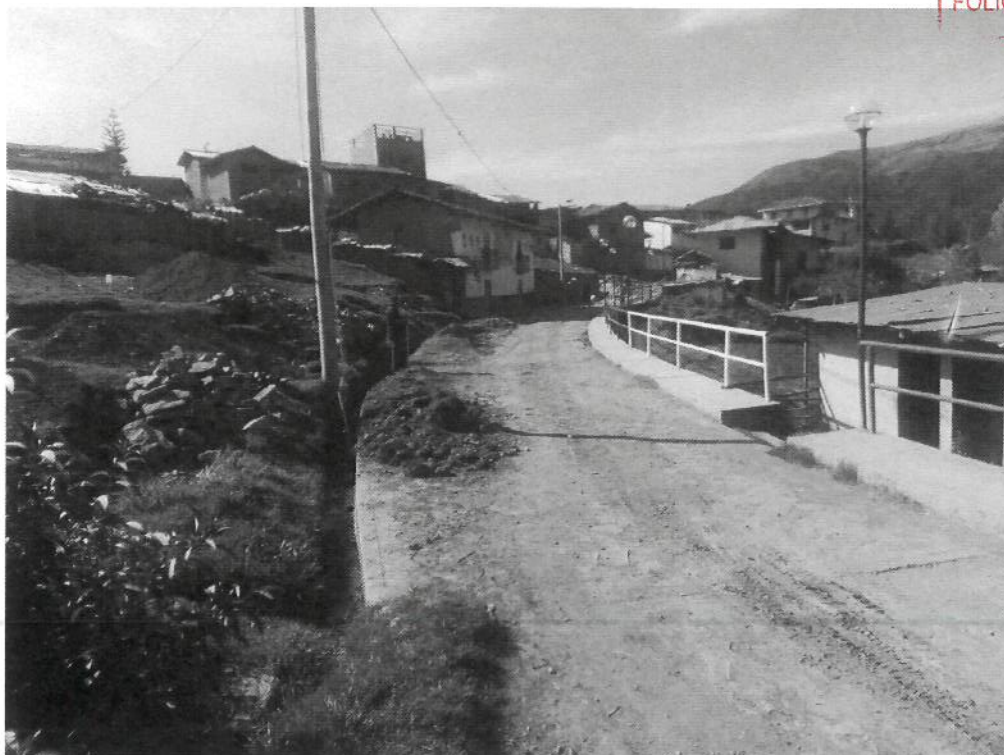
TRAMOS DEL CANAL ASENTADO POR LAS LLUVIAS EN LA LOCALIDAD DE HUANDOVAL.
