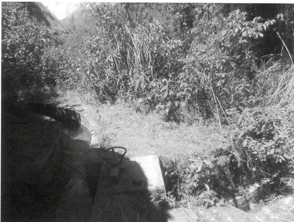
Compuerta de Limpia del Desarenador.
