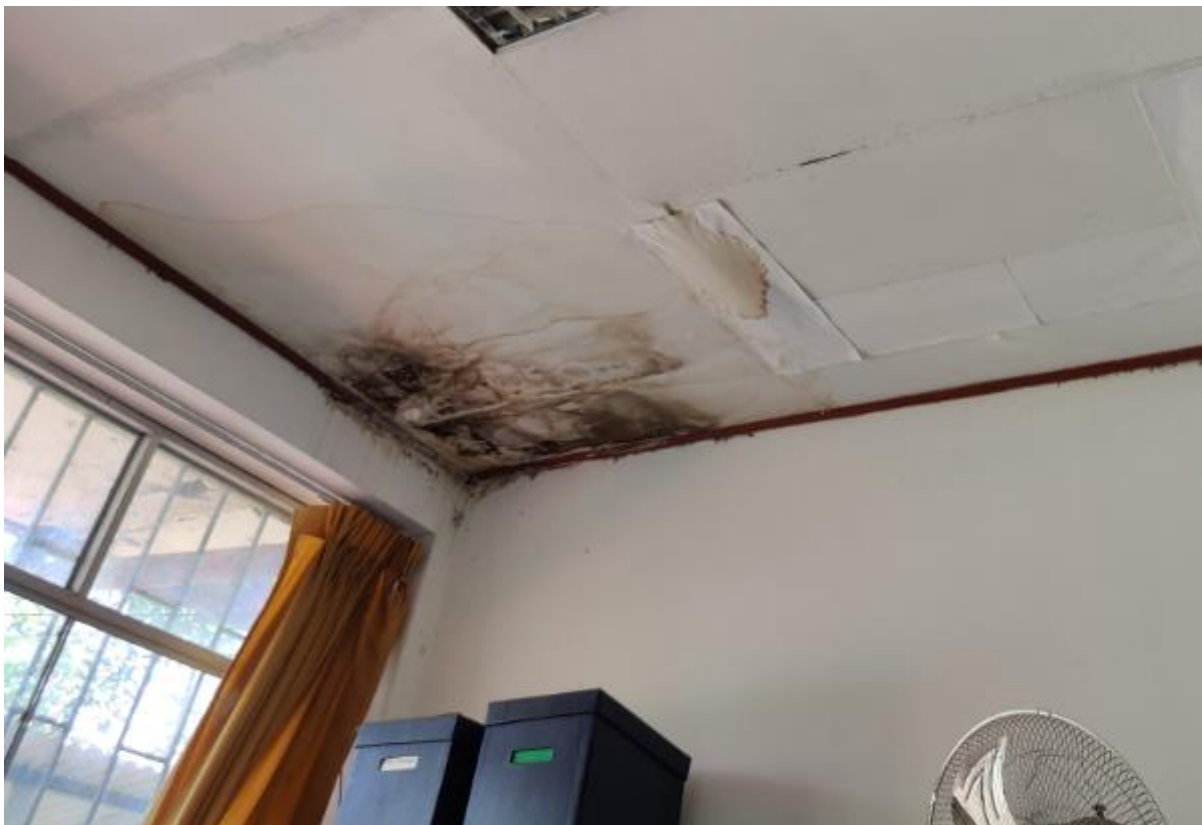
Foto 15: Mancha de humedad en cielo raso de asesoría legal.
