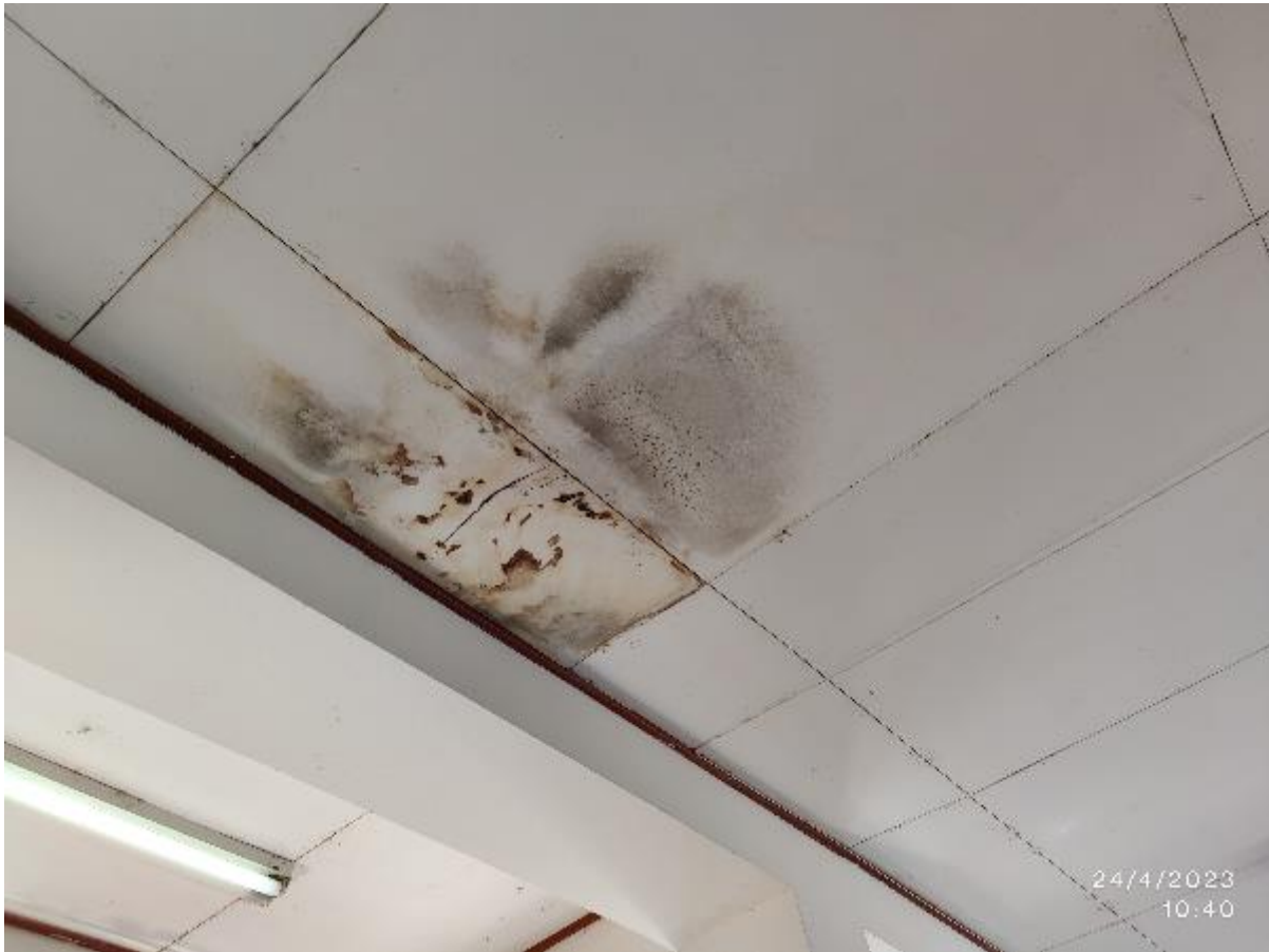
Foto 14: Macha de humedad en cielo raso de hall de distribución.
