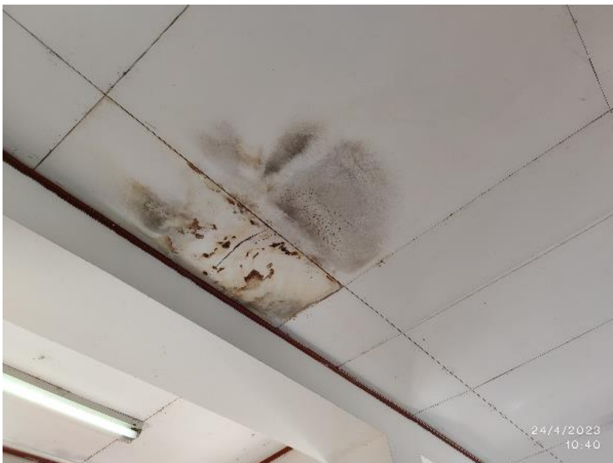
Foto 14: Mancha de humedad en cielo raso de hall de distribución.
