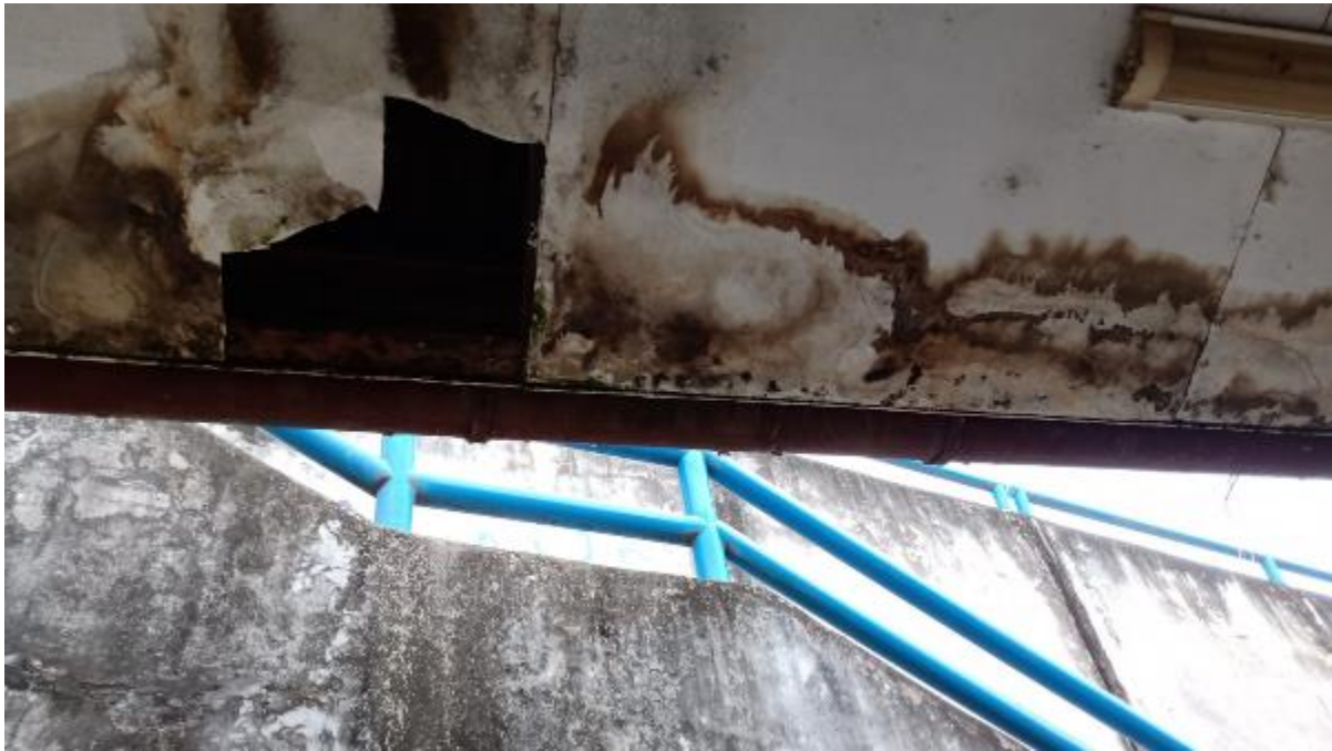
Foto 18: Cielo raso en alero dañado por la humedad.
