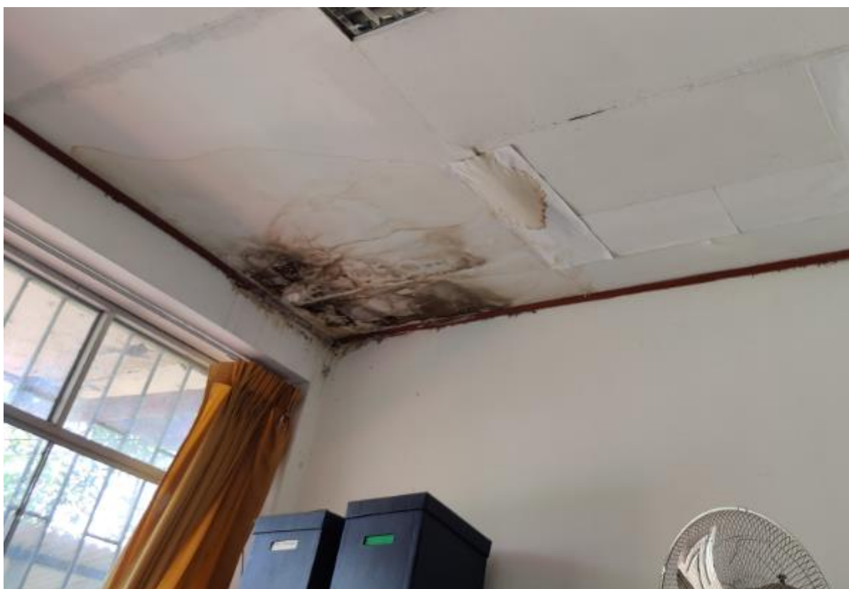
Foto 15: Mancha de humedad en cielo raso de asesoría legal.
