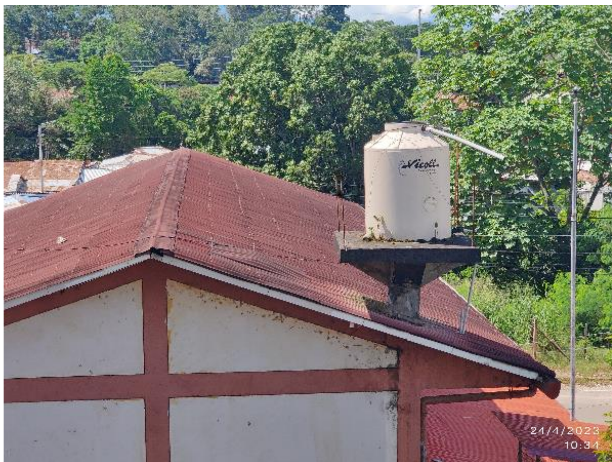
Foto 20: Intersección entre cobertura y columna de soporte del tanque elevado.
