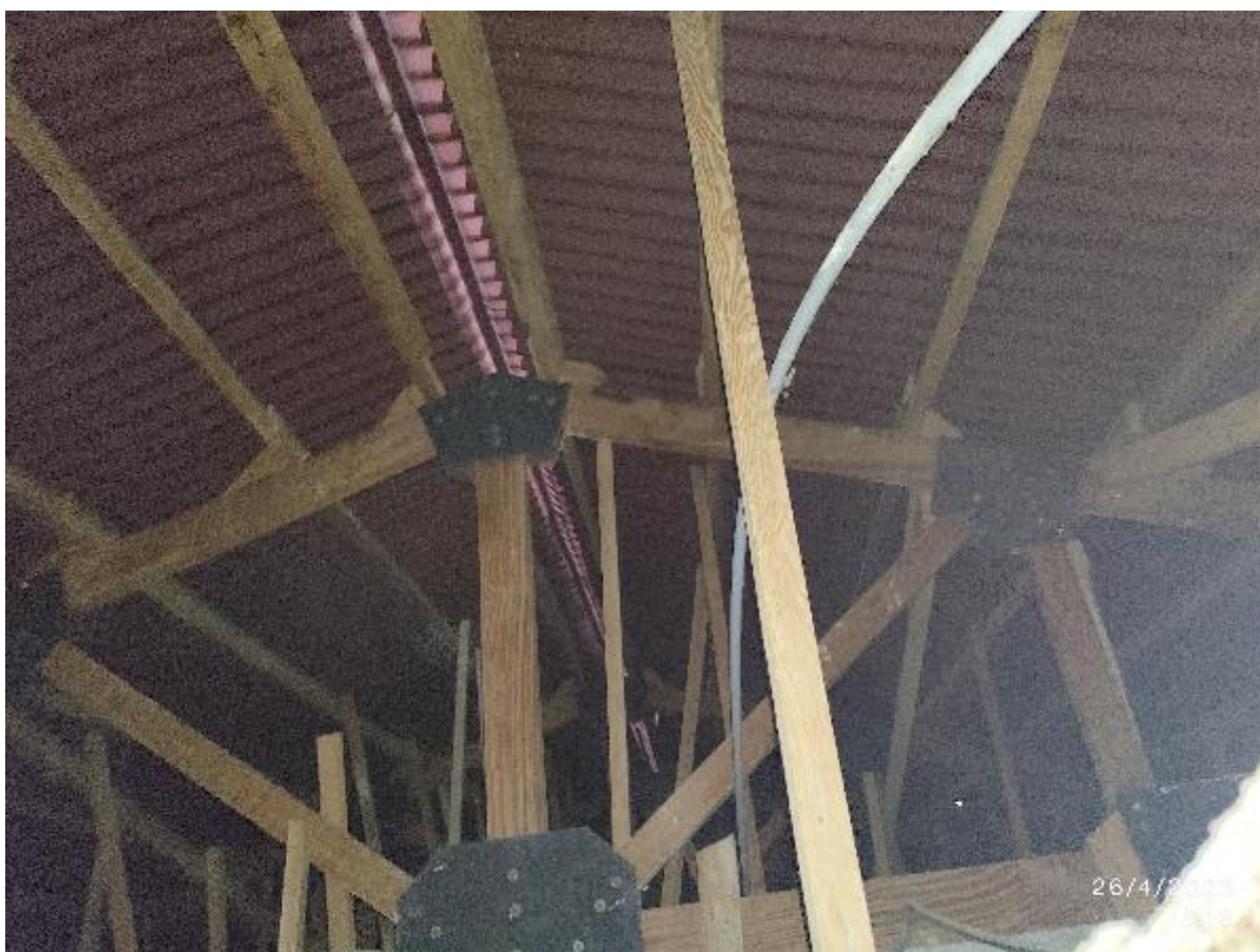
Foto 22: Estructura de soporte de la cobertura.
