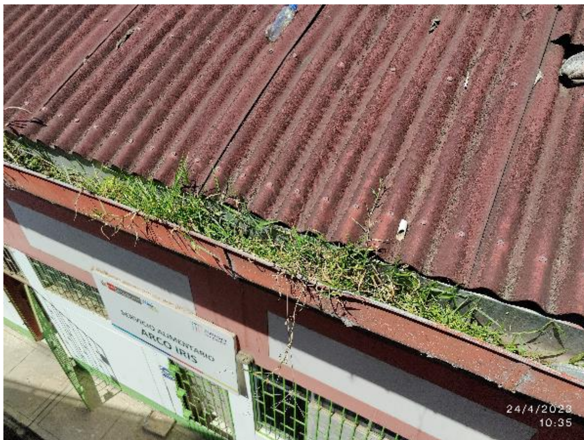
Foto 19: Canaleta pluvial.
