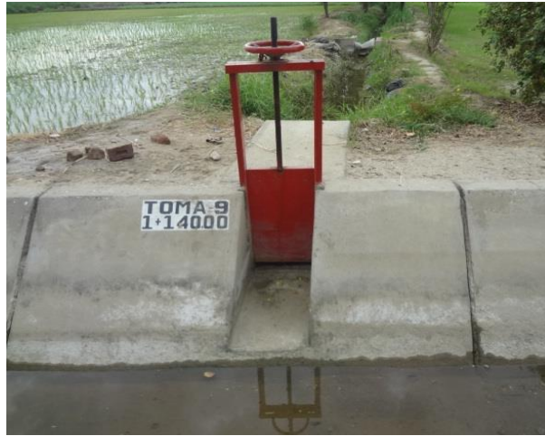
TOMA DE CANAL DE TERCER ORDEN Y SEGUIDO DEL CANAL DE TIERRA A MEJORAR EN EL PROYECTO
