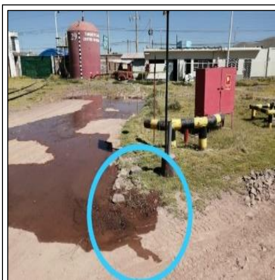
Figura N° 01: Fuga de agua de la Red Contra Incendio
