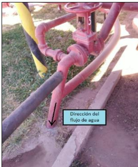
Figura N° 03: Extremo de la tubería que sale de la bomba hale.
