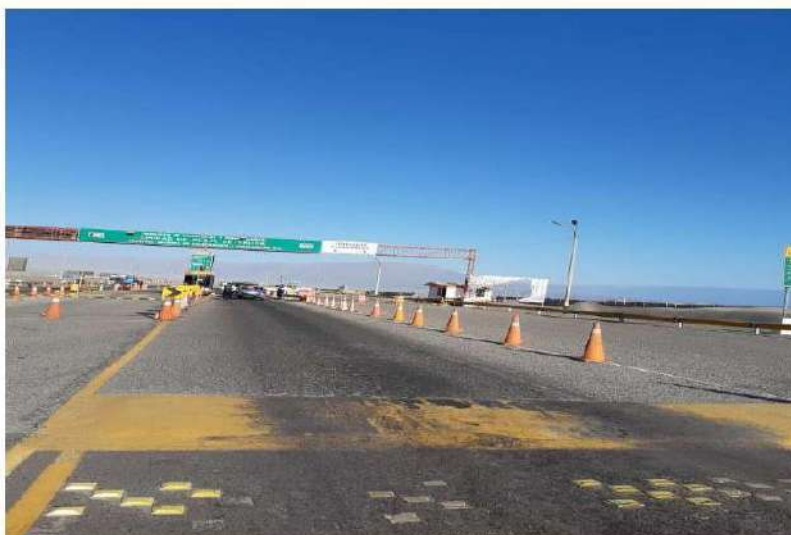
Fotografía N°5: Inexistencia de protectores de impacto
