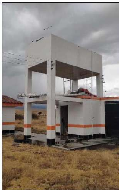
Fotografía N° 17: Tanque elevado de almacenamiento de agua.
