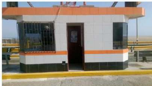
Vista lateral de la caseta de cobro, la cual se encuentra revestida con mayólica en el exterior (lado derecho).
