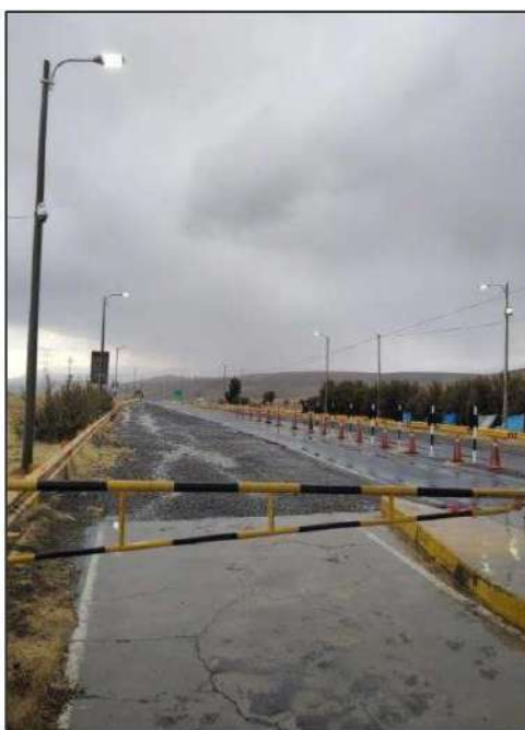
Postes de iluminación exterior con luminarias tipo led
