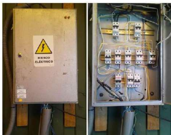
Fotografía N° 19: Tableros de control.
