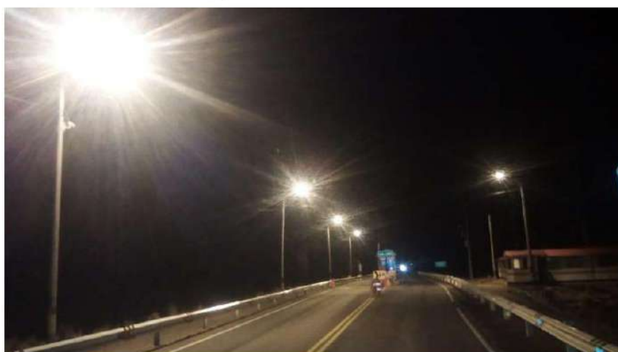
Postes de iluminación exterior con luminarias tipo vapor de sodio
