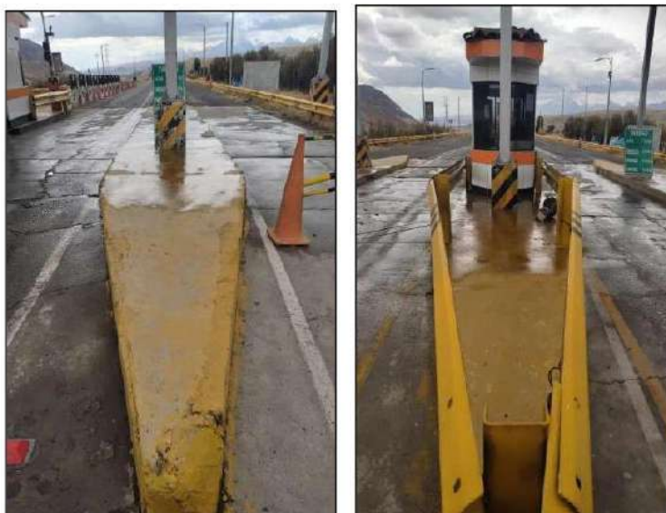
Fotografía N°5: Inexistencia de protectores de impacto
