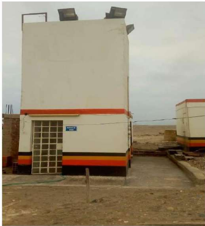
Fotografía N° 16: Tanque elevado de almacenamiento de agua.
