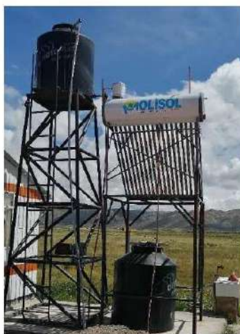
Fotografía N° 14: Tanque elevado de almacenamiento de agua.
