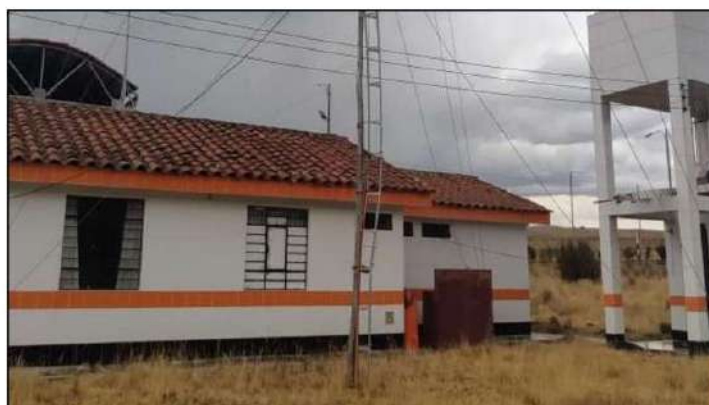
Fotografía N°19: Inexistencia de sistema de drenaje pluvial.
