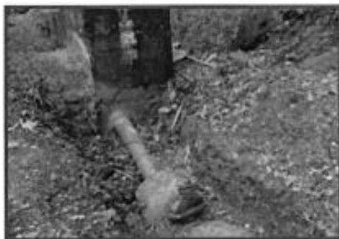
Válvula inoperativa en línea de conducción
