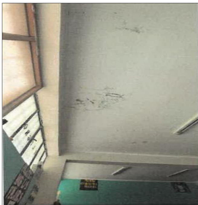
Vista fotográfica N°10: Vista de filtraciones
