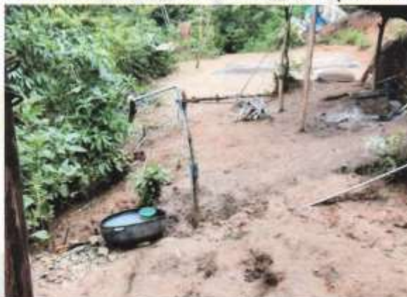
IMAGEN N° 06: Conexión Domiciliaria Expuesta en mal estado
