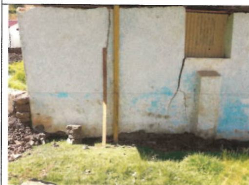
Foto N° 05 : Grieta en la pared posterior.
