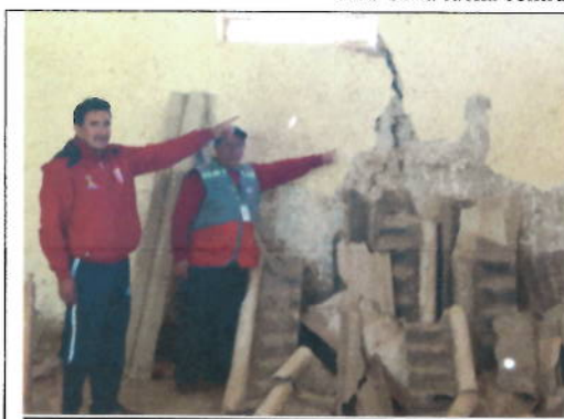
Foto N° 03: Rajadura total del muro en uno de los ambientes en inminente colapso.
