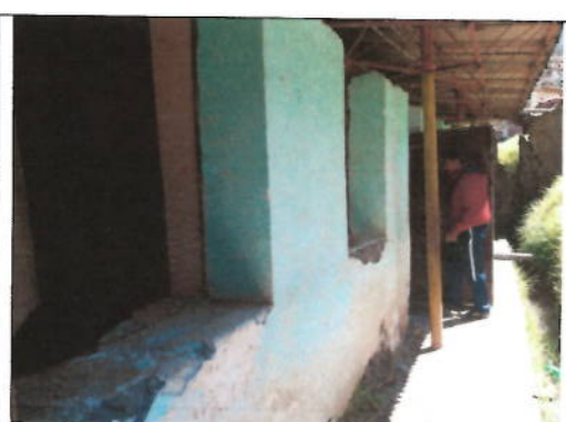
Foto N° 02 : Se aprecia rajaduras en la ventana de adobe.
