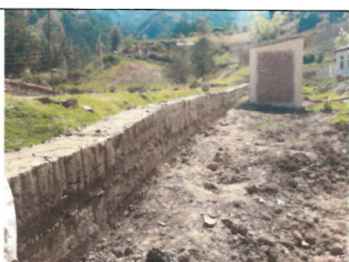
Foto N° 02 : Se aprecia cerco perimétrico de tapial colapsado, en proceso de reconstrucción.
