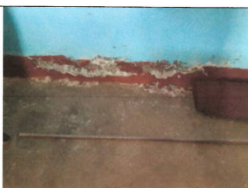
Foto N° 06 : Se aprecia deterioro del pared por la humedad.
