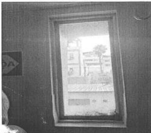
IMAGEN 13: DETERIORO EN EL LAMINADO DEL VIDRIAL.
