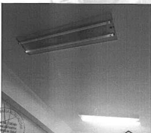
IMAGEN 11: LUMINARIA SIN FUNCIONAMIENTO CON FALTA DE MANTENIMIENTO.
