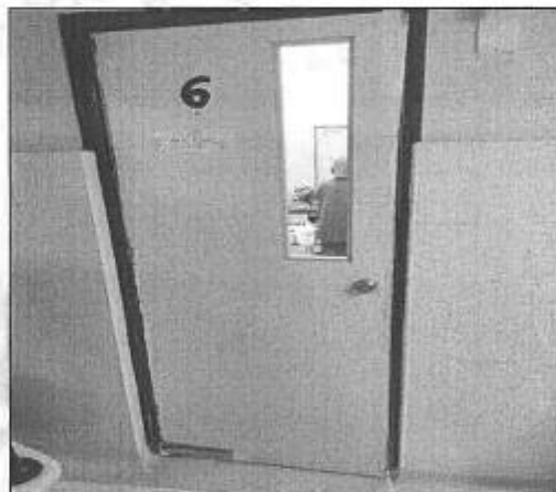
IMAGEN 16: MARCO Y PUERTA DETERIORADA.
