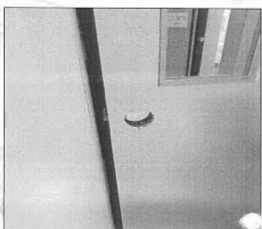
IMAGEN 89: PUERTA SIN CHAPA Y DETERIORADA.
