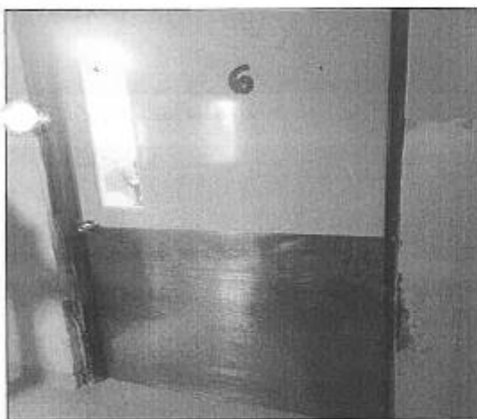
IMAGEN 66: DETERIORO Y DESGASTE EN EL MARCO Y PUERTA A CAUSA DE LA FALTA DE MANTENIMIENTO.
