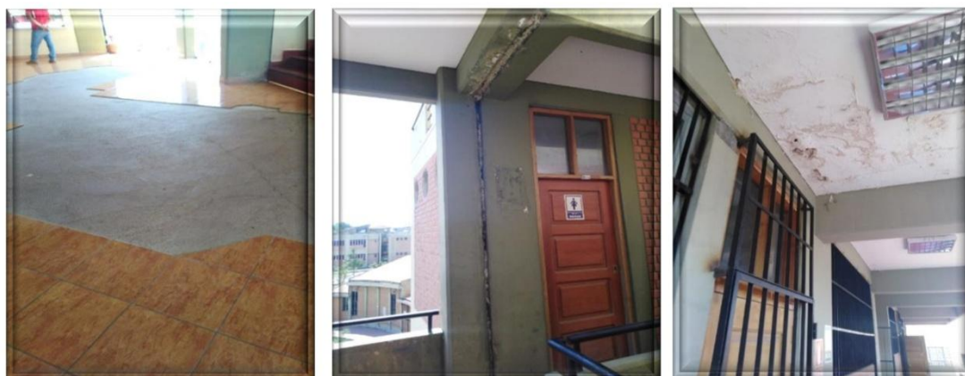
Vista N° 02 Piso de cerámico levantado en el 2do piso del módulo Administrativo, será necesario evaluar de manera integral las condiciones físicas de la Infraestructura de la Facultad de Ciencias Sociales.
