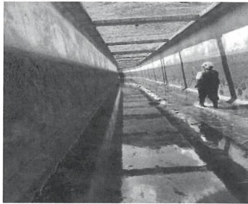
Figura 6: Presencia de vegetación en canales abiertos
