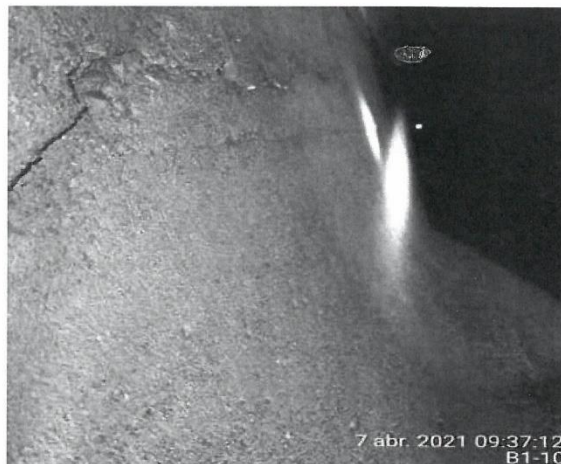
Figura 7: Daños en hastiales de túneles
