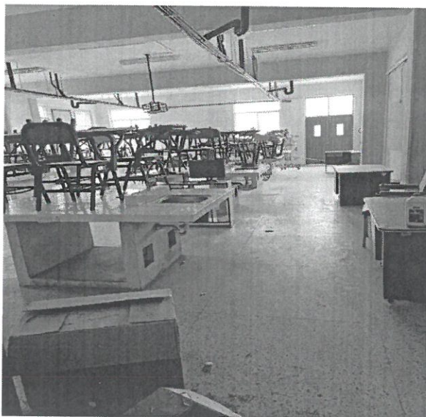
Foto 14: Se observa que en las mesadas sus válvulas esféricas, llave tipo ganso y trampas se encuentran en mal estado, piso desgastado por el uso cotidiano, luminarias quemadas, cielo raso sucio y despintado, ausencia de mobiliario de melamina en mesadas laterales y centrales.
