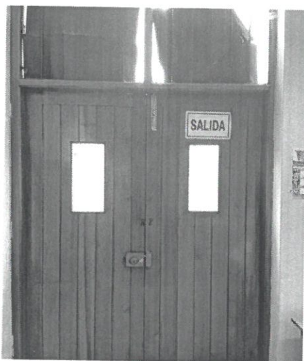
Foto 03: Se observa el protector de puerta oxidado, ausencia de vidrio de puerta, cerradura en mal estado, cortina deteriorada por el uso cotidiano.
