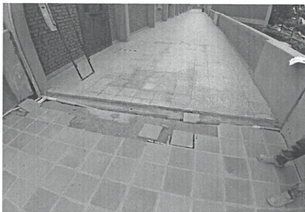
Foto 31: Se observa ausencia de revestimiento y tubería expuesta.
