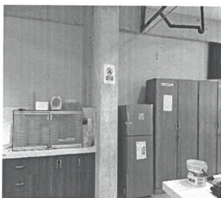
Foto 01: Se observa muros despintados, columnas y vigas sin revestimiento de pintura
