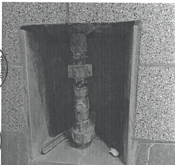
Foto 20: Se observa válvula esférica en mal estado.
