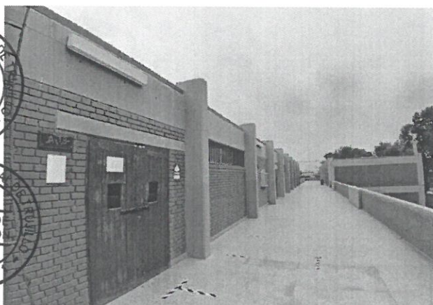
Foto 32: Se observa puertas de la azotea en mal estado, sin vidrio y luminarias quemadas.
