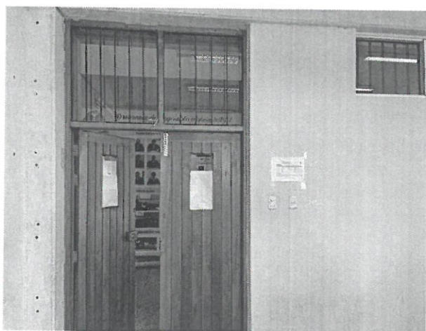
Foto 12: Se observa que la puerta tiene ausencia de vidrio y despintadas por el uso cotidiano, muros manchados, ausencia de cortinas en las ventanas, columnas y vigas sin revestimiento de pintura.
