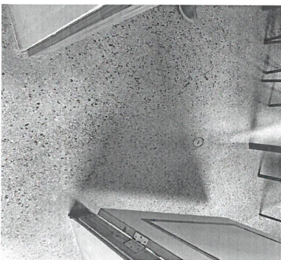
Foto 26: Se observa que la puerta no encaja en los vanos de los muros de drywall, piso desgastado por el uso cotidiano.
