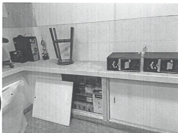
Foto 09: Se observa puertas de melamine en mal estado, ausencia de contra zócalos en las mesadas, muros de mesada despintadas.
