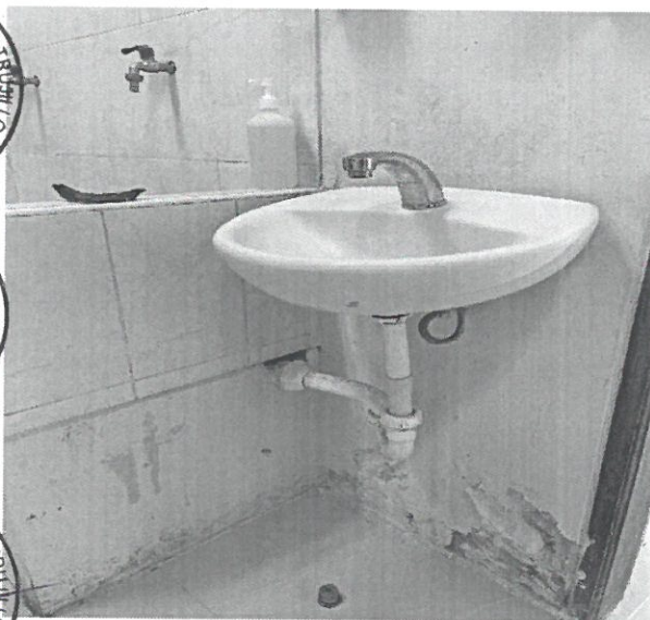
Foto 15: Se observa que el lavamano se encuentra en mal estado, trampa obstruida, muros despintados, ausencia de zócalo en la zona del lavamanos y pedal sin funcionamiento.
