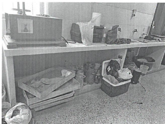
Foto 08: Se observa ausencia de separadores en las mesadas, piso desgastado por el uso cotidiano, muros de mesadas despintadas, ausencia de contra zócalos en mesadas.
