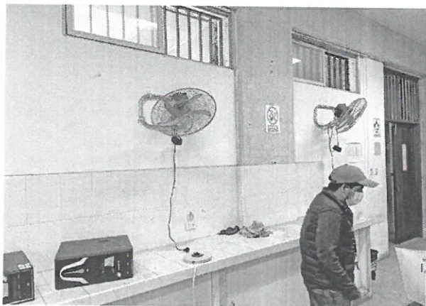
Foto 11: Se observa ausencia de cortinas en ventanas, columnas y vigas sin revestimiento de pintura, tomacorrientes en mal estado y protectores de ventanas oxidados.
