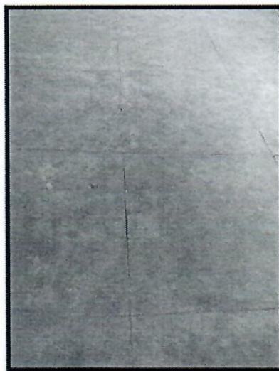
FOTOGRAFÍA N° 03 – PISOS EN MAL ESTADO, PRESENCIA DE GRIETAS
