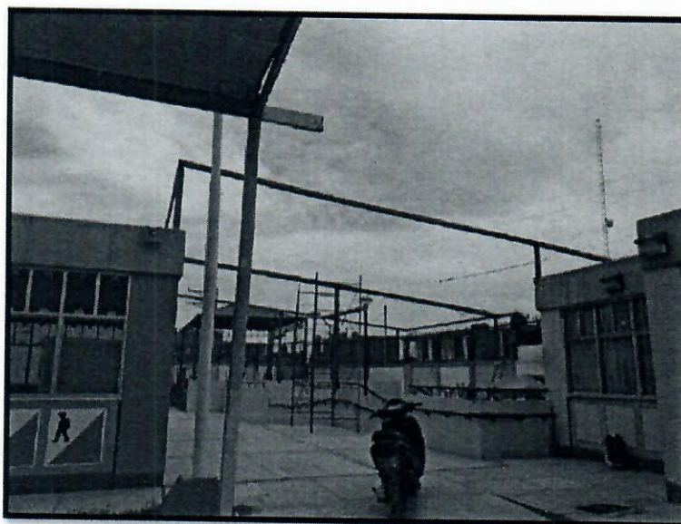
FOTOGRAFÍA N°02 – COLOCACIÓN DE COBERTURA EN PATIO.
