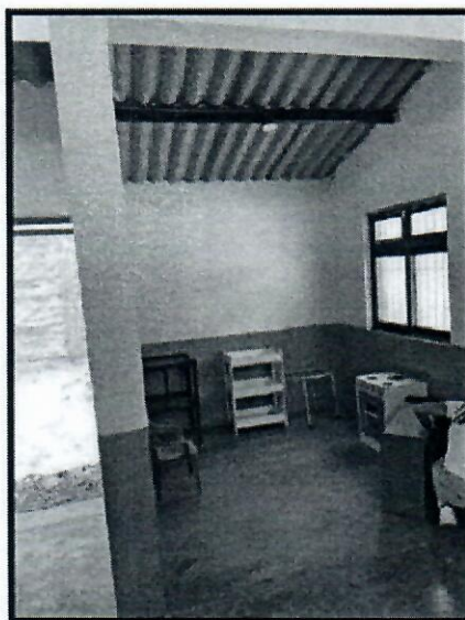
FOTOGRAFÍA N° 03 – PISOS DE AULA ACADEMICA A INTERVENIR CON COLOCACION DE PISO CERAMICO 45X45
