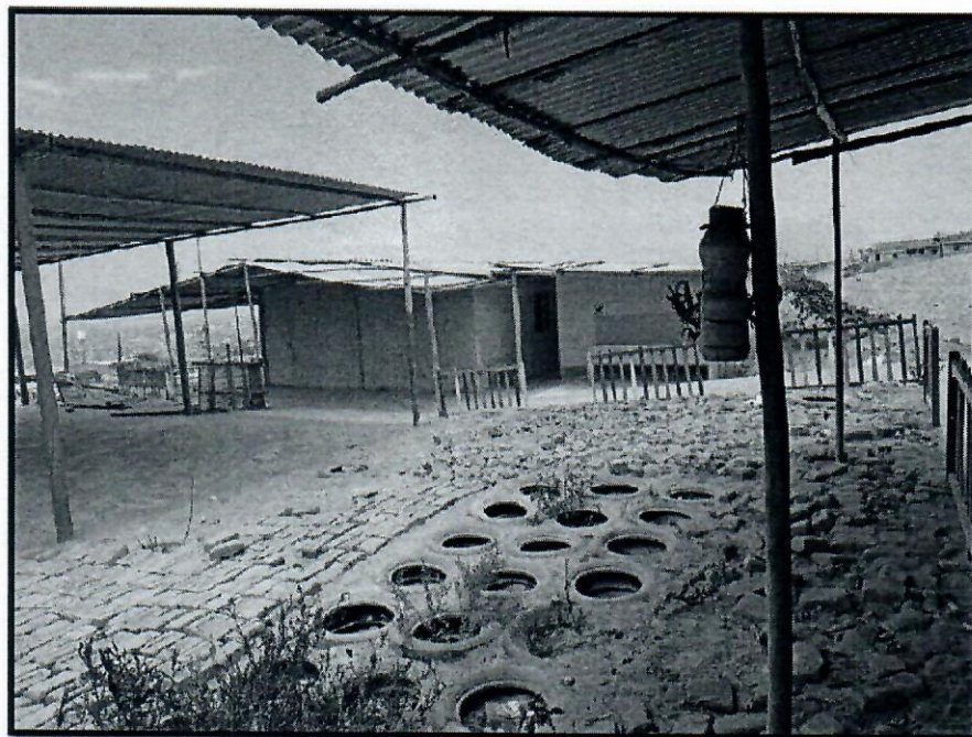
FOTOGRAFÍA N° 03 – PISOS DE AULA ACADEMICA A INTERVENIR CON COLOCACION DE PISO CERAMICO 45X45
